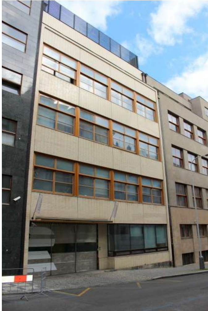
22/ Praha, Balbínova ulice, budova Českého rozhlasu, Karel Tausenau a kol., 1947-51.
