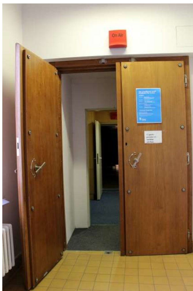
19/ Praha, původní zvukotěsné dveře Studia II.
