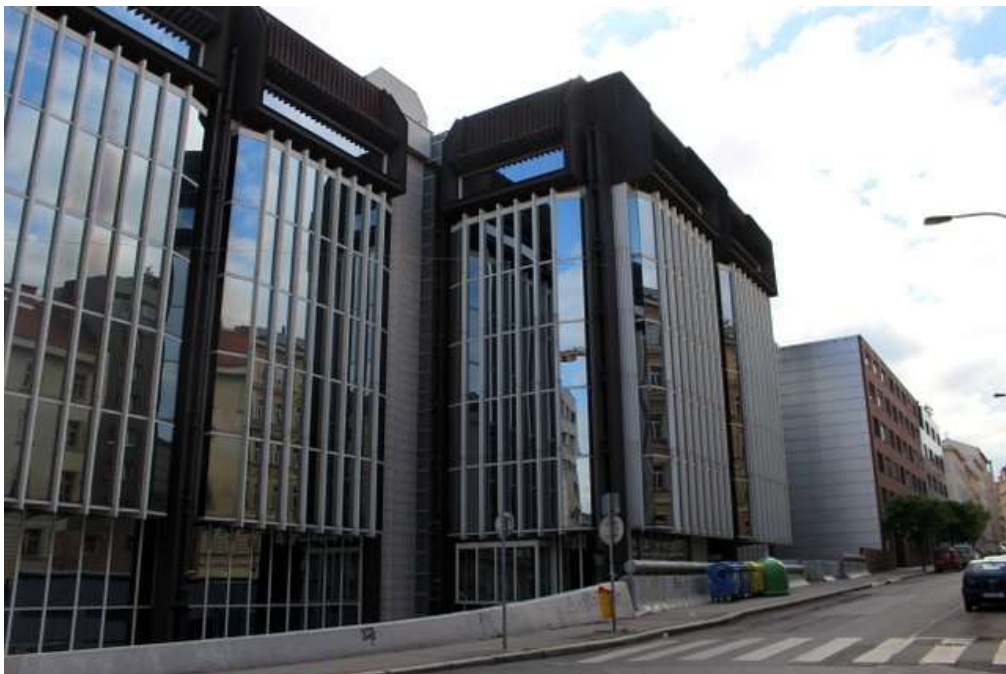
32/ Praha, Římská ulice, budovy Transgasu, Ivo Loos - Jindřich Malátek – Jiří Eisenreich – Václav Aulický, 70. léta 20. století.
