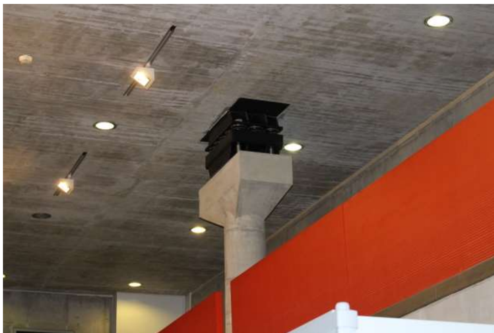
39/ Praha, Studiový dům Rozhlasu – pružiny pod studiovou částí, A.D.N.S., 1996-2000.
