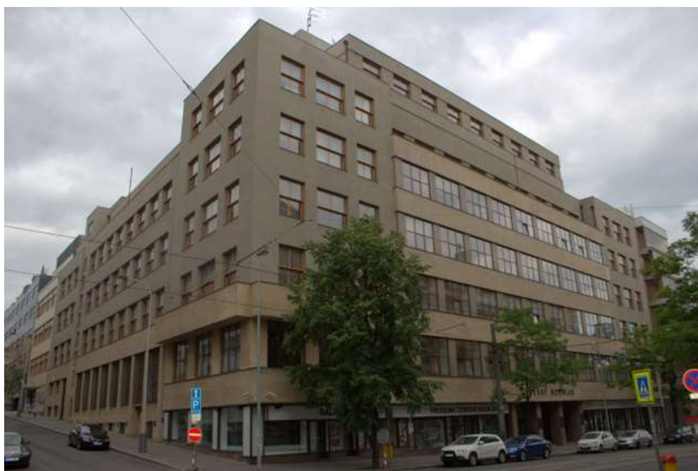
17/ Praha, nároží Balbínovy a Vinohradské ulice, budova Českého rozhlasu, Bohumil Sláma, 1927-33.
