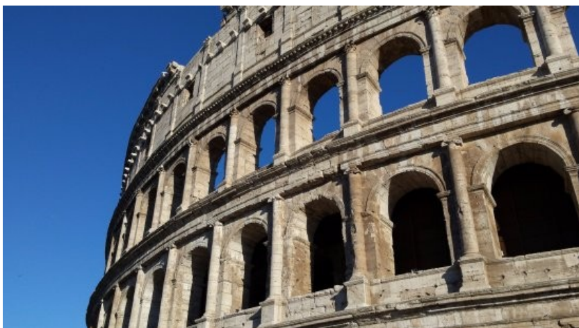
5. Řím , pilířové arkády Kolosea se superpozicí sloupového řádu
