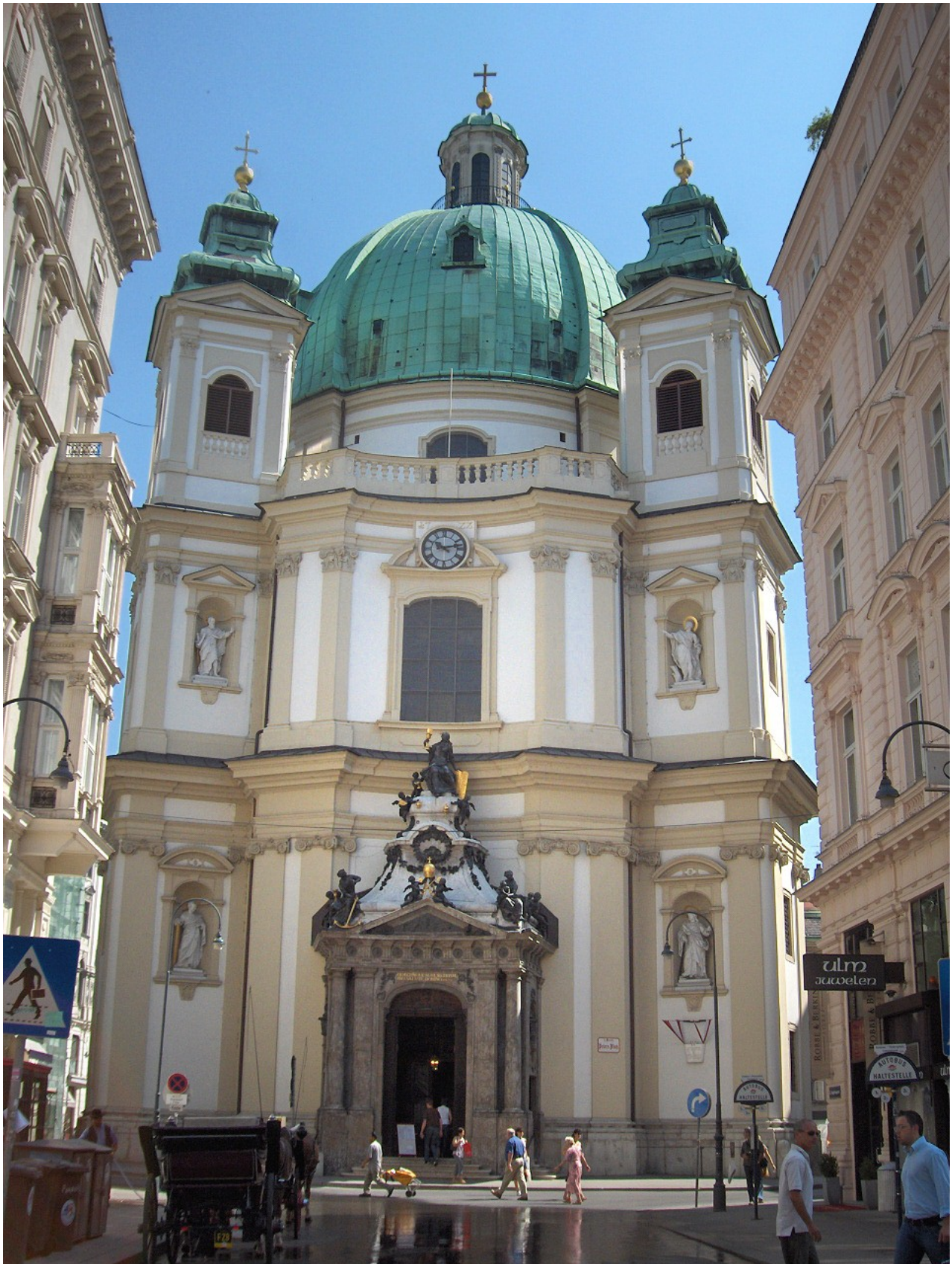
51. Vídeň, kostel sv. Petra, pohled na průčelí
