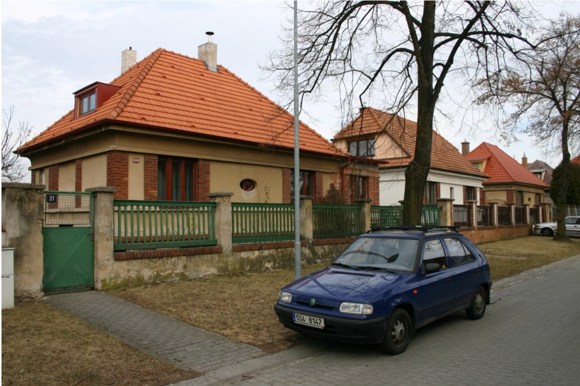
4 Ulice Lipová v Čelákovících. Foto M. Sedlák.
