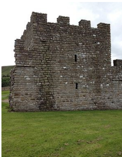
Obr. č. 21 – Rekonstrukce obranné věžičky na Hadriánově valu.
