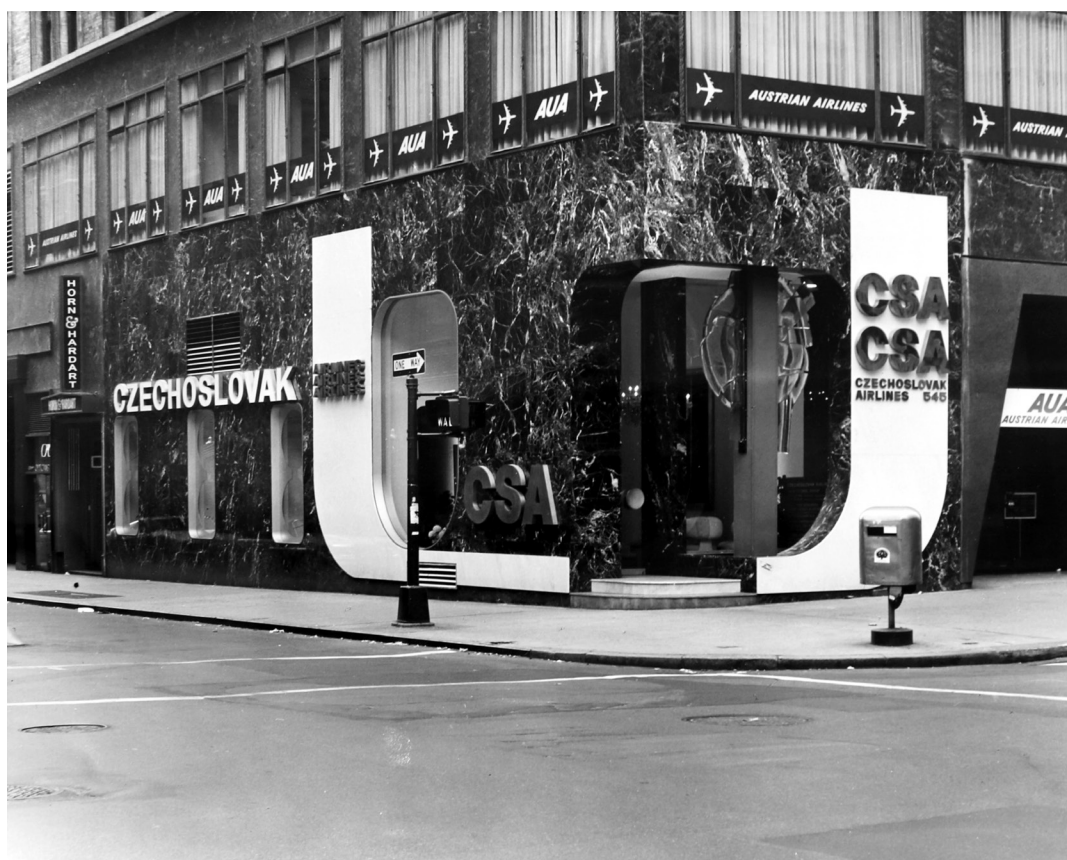
87. New York, cestovní kancelář ČSA, 1969–1970, portál s plastikou od Stanislava Libenského a Jaroslavy Brychtové, 1970
