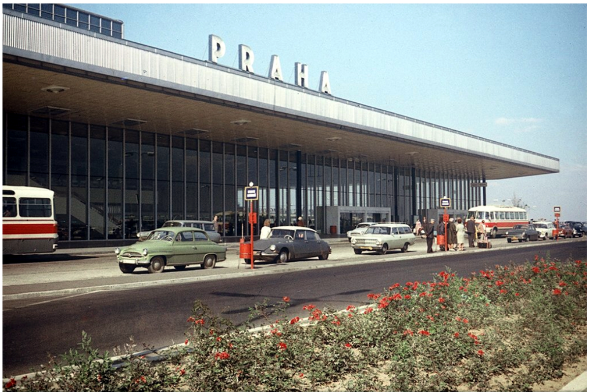
106. Pohled na odbavovací budovu
