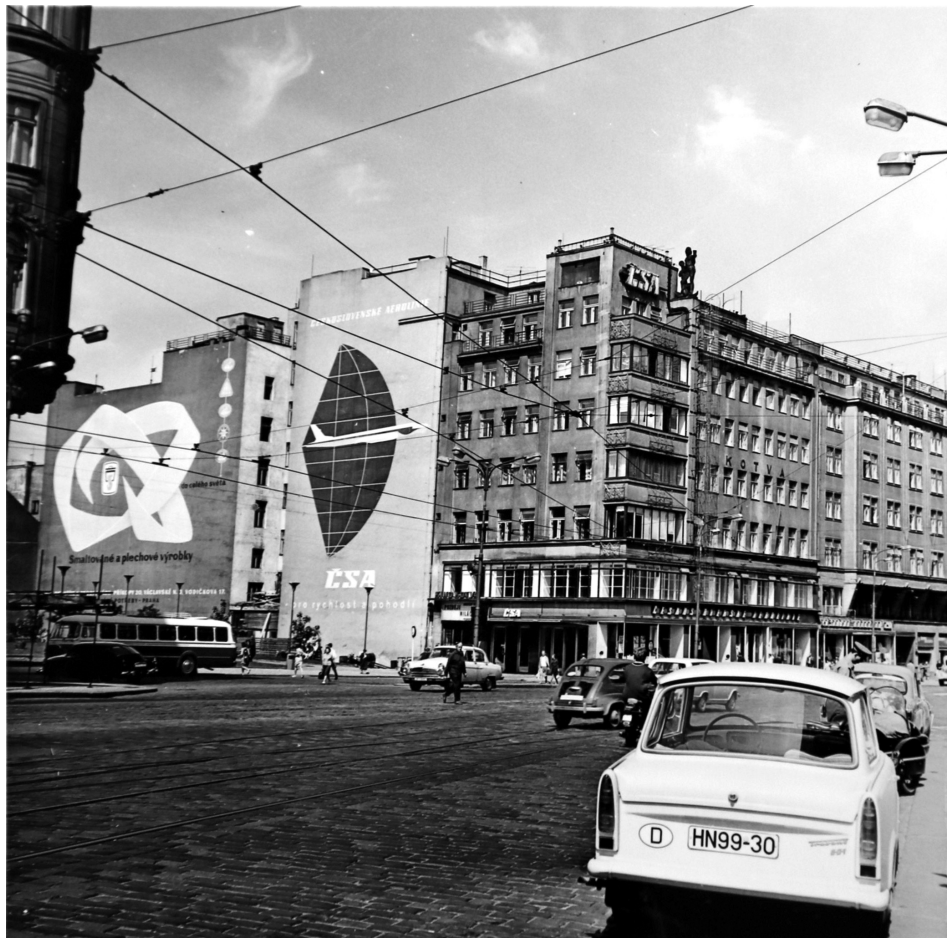
(c) nové letecké centrum ČSA v přízemí paláce Kotva
