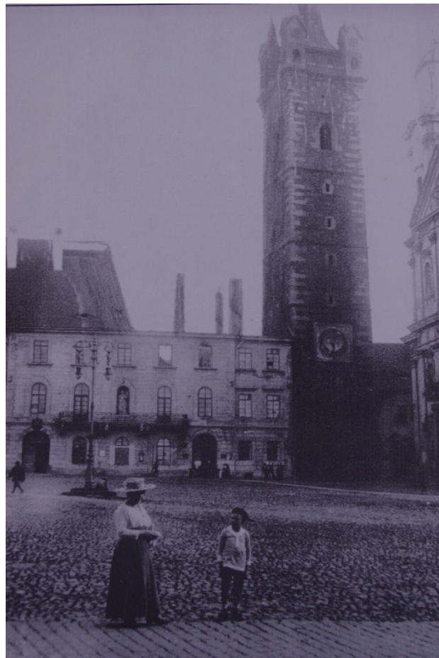
[5] Klatovská radnice, stav po požáru
