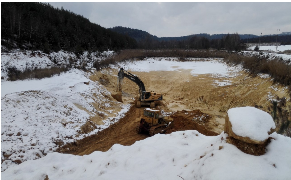
Obrázek 37: Vyvážení kalu z nádrže při současném budování cesty.
