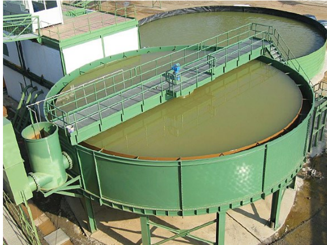
Obrázek 16: Kruhové usazovací nádrže na vyvýšené konstrukci. Zdroj: Ampmineral.
