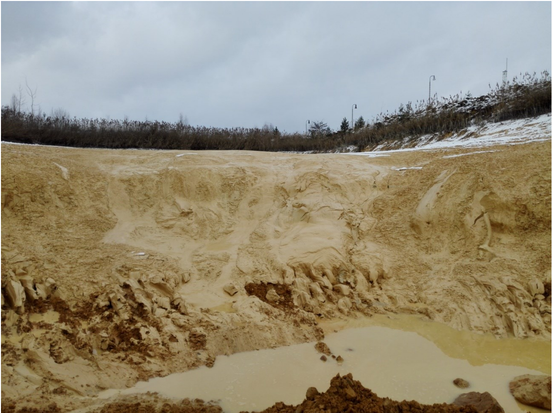
Obrázek 50: Pohled na resedimentovaný kal při vybírání usazovací nádrže.
