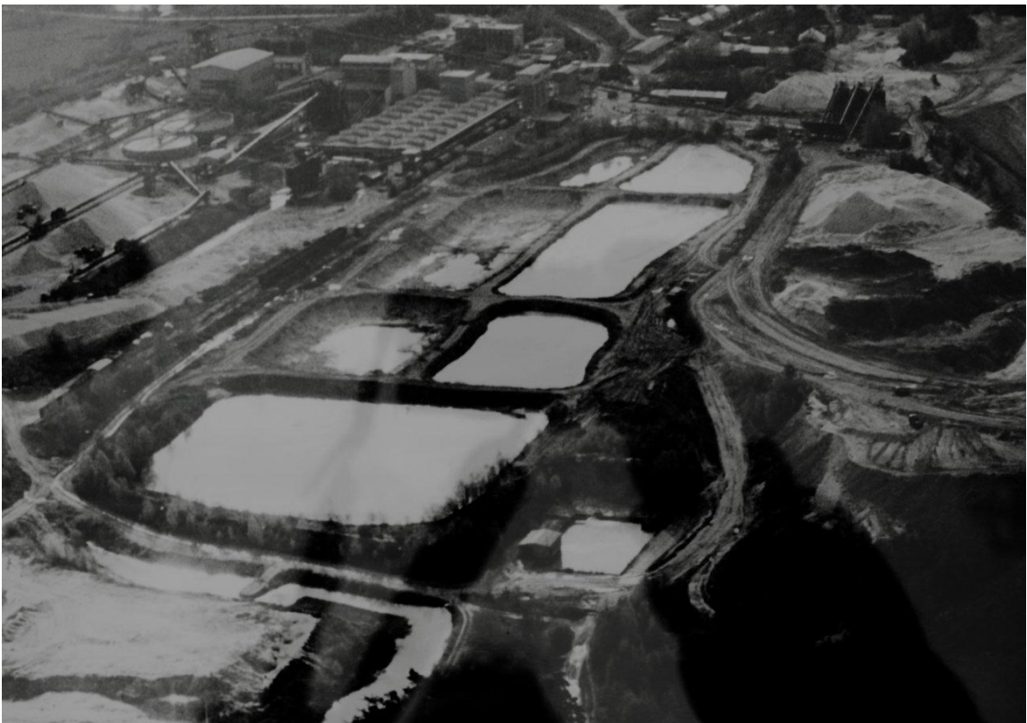
Obrázek 6: Soustava rozšířených usazovacích nádrží. Stav před rokem 1998 po zrušení hydrocyklonových stanic a před vybudováním ochranného valu. Zdroj: Sklopísek Střeleč a.s.
