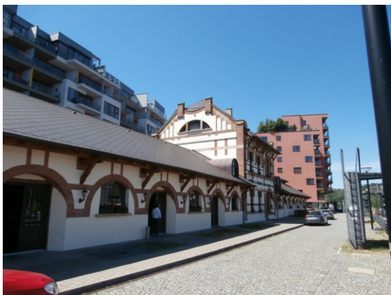
Obr. 141: Bývalá skladová přístavní budova, dnes holešovický minipivovar a zároveň technická památka Foto: J. Brabec (2017)
