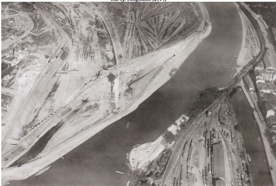
Obr. 140: Oblast Manin, kde lze vidět probíhající práce na přeložení koryta blíže k Holešovickým, v popředí Rohanský ostrov s ještě existujícím Karlínským přístavem, foto z roku 1926 Zdroj: Jungmann (2014)
