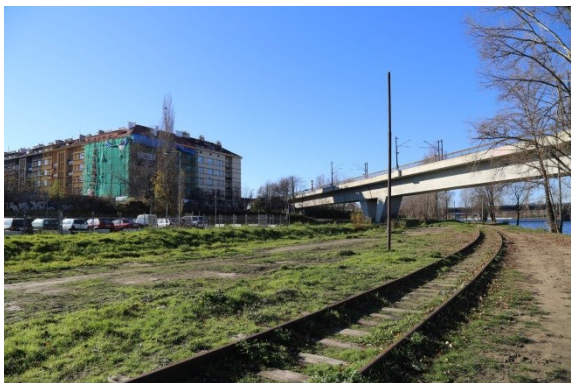
Obr. 143: Zarostlá železniční vlečka vedoucí do Holešovického přístavu, již není využívána Foto: D. Fialová (2016)
