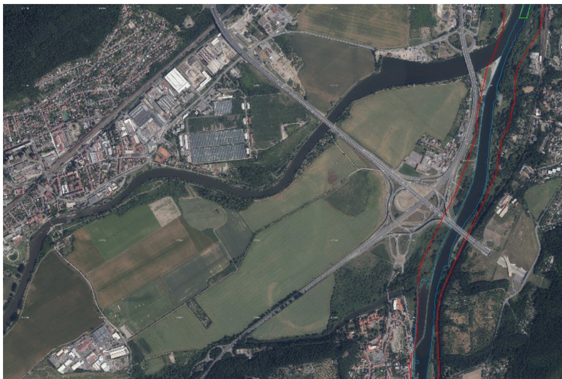
Obr. 101: Oblast soutoku s Berounkou, dole lze vidět PP Krňák (bývalé rameno Berounky), dálniční křížení dálnic D4 a D0, zemědělské plochy – plánovaný městský park Zdroj: vlastní vektorizace, ČÚŽK (2017) (ML-195?, ČL-183?, ZL-193?)
