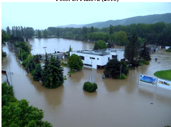
Obr. 13: Golfový resort Hodkovičky během povodní 2013 Zdroj: Svobodová (2014)
