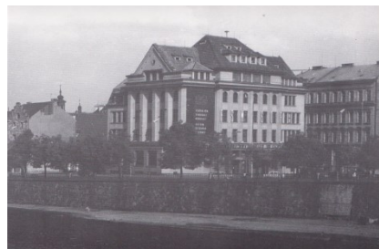
Obr. 57: Dům Svazu architektů a inženýrů, foto z roku 1966 Zdroj: Bečková (2003a)
