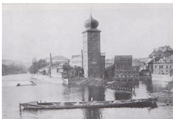
Obr. 43: Pohled po vodě na skupinu Šítkovských mlýnů, zůstala jen vodárna, foto kolem 1885 Zdroj: Wirth (2003)
