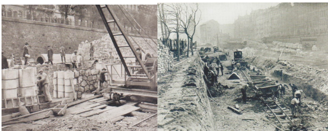
Obr. 117: Stavební práce při stavbě plavební komory mezi Janáčkovým nábrežím a Dětským ostrovem, foto z roku 1912 Zdroj: Jungmann (2007)
