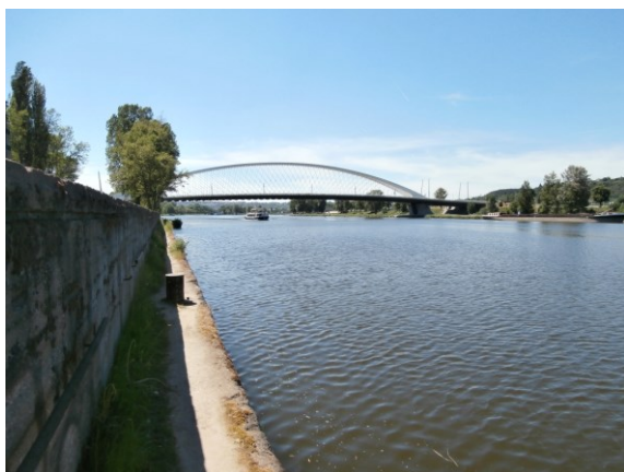
Obr. 146: Bývalá oblast Zátor, kde bylo Holešovické nábřeží, dnes průchod sotva pro jednu osobu u bývalé panelárny Foto: J. Brabec (2017)
