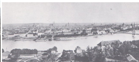
Obr. 50: Pravé pobřeží Vltavy v oblasti od železné lávky směrem Na František, kolem 1870 Zdroj: Wirth (2003)
