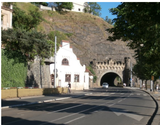
Obr. 26: Severní portál Vyšehradského tunelu, stejné místo jako Obr. 27 Foto: J. Brabec (2017)
