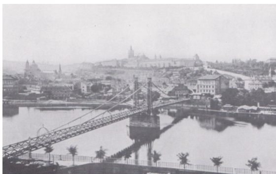
Obr. 123: Železná lávka se stále stojícím mýtným domkem, foto kolem 1880 Zdroj: Wirth (2003)
