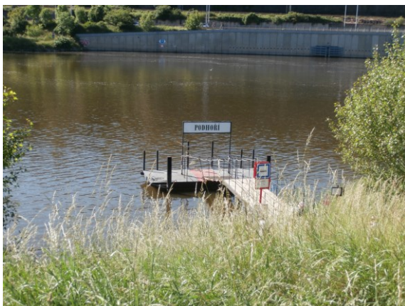
Obr. 93: Přístaviště přívozu P2 na pravém břehu Foto: J. Brabec (2017)
