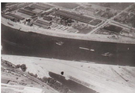
Obr. 137: Areál jatek u již nového koryta, dole na obázku právě zasypávané staré rameno, foto z roku 1927 Zdroj: Jungmann (2014)
