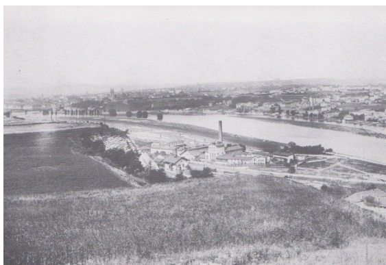
Obr. 106: Pohled na zličovský lihovar v okolí Císařské louky, dnes zcela zastavěno dopravními stavbami, foto z roku 1926 Zdroj: Bečková (2004)
