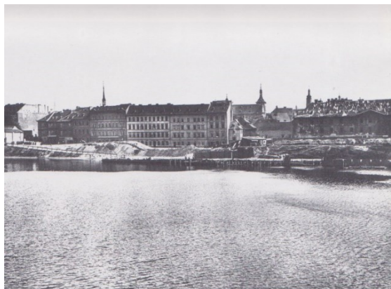
Obr. 58: Stavba nábreží Na Františku u Anežského kláštera, na obrázku Transporthaus, vstup do kláštera a několik činžovních domů, foto z roku 1912 Zdroj: Bečková (2003a)
