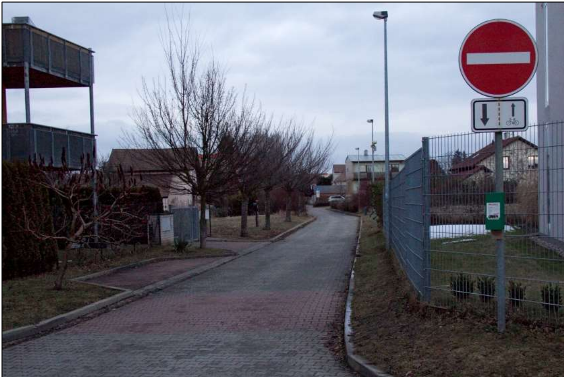
Obr. 6: Jednosměrná komunikace s obousměrným provozem jízdních kol (bez oddělení protisměrného prostoru) v ulici Sychrovská, Kbely (Praha 9). Foto autor
