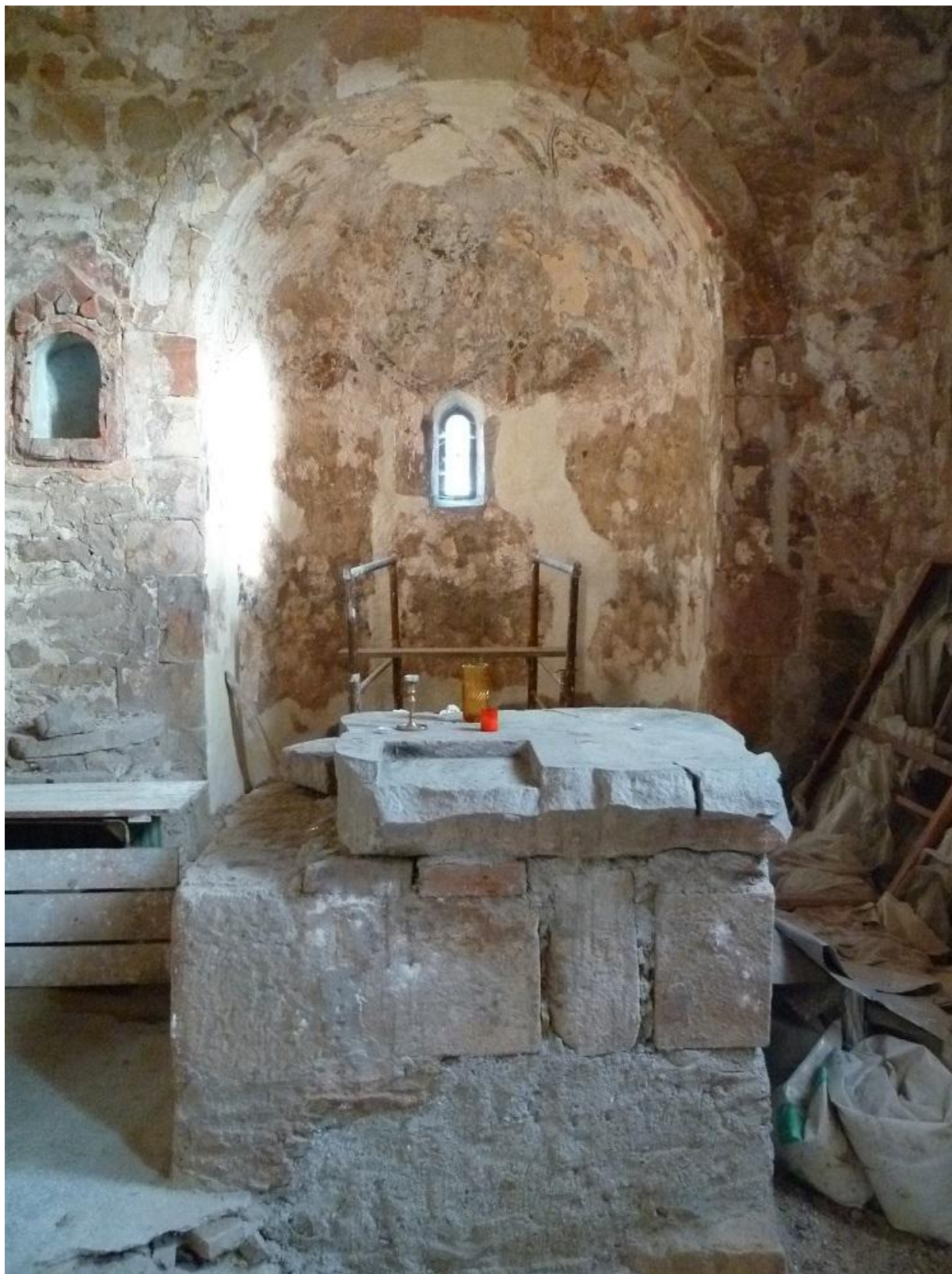
Obrázek 26 Pohled do apsidy kostela přes oltární menzu
