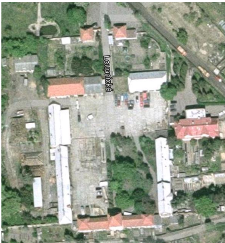
26. Janov, zámek s areálem hospodářského dvora, letecký pohled. Nahoře dva vstupní objekty, navazuje úsek ozdobně tvarované zdi.
