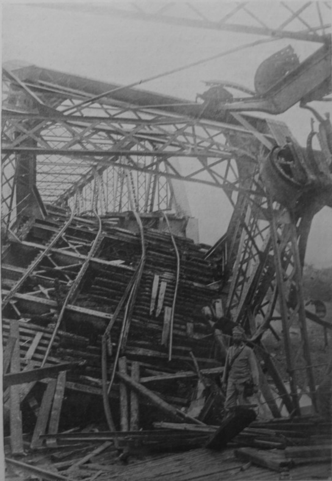
Zničený most při ústupu Rusů.
