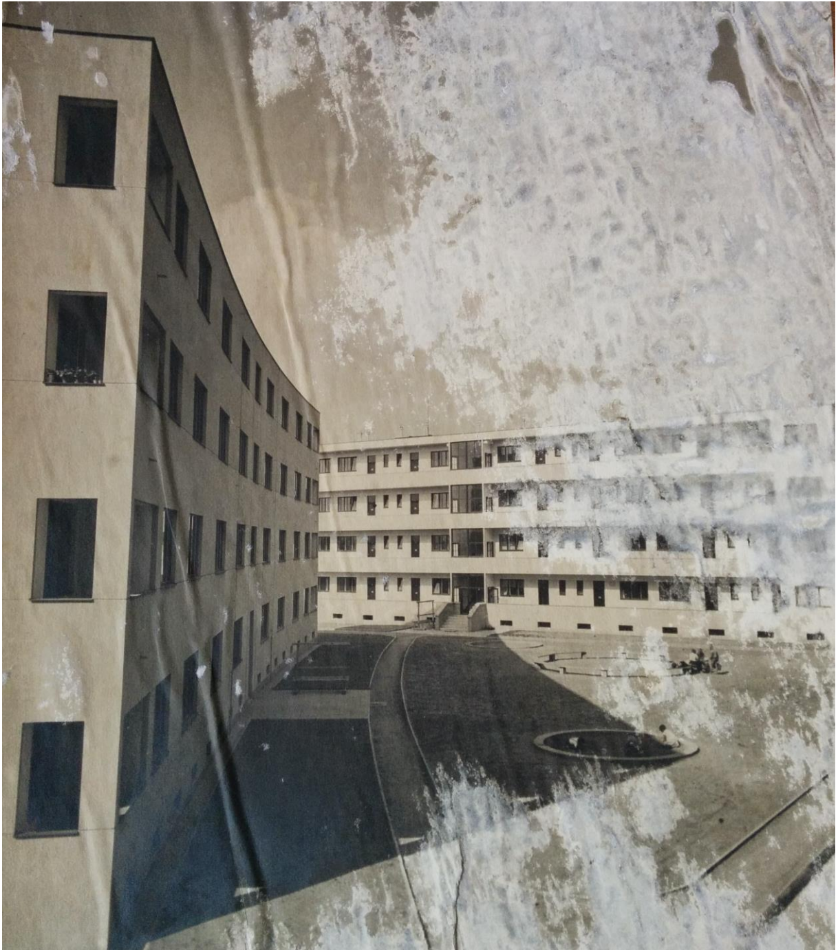
27. František A. Libra, Jiří Kan: Domy OPAS v bloku E, stav těsně po dokončení , vlevo dům sledující zakřivení bloku, rok 1934
