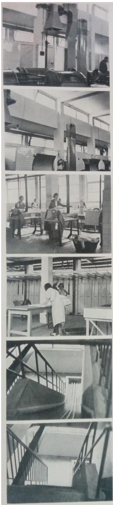
d) zařízení strojové prádelny pro domy OPAS, dobová fotografie, zřejmě rok 1934
