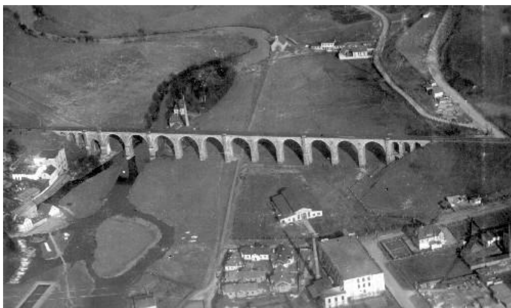
13. Viadukt v roce 1927
