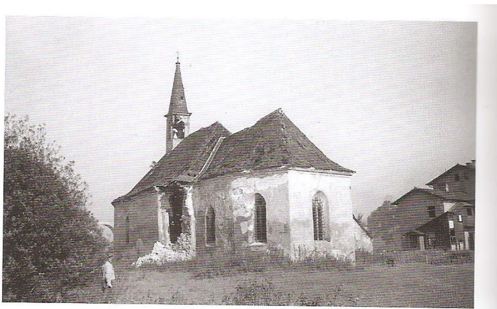
19. Kostel sv. Jošta za viaduktem při zřízení první státní v roce 1953. Kostel i vedlejší chudobinec během několika let zbourány.
