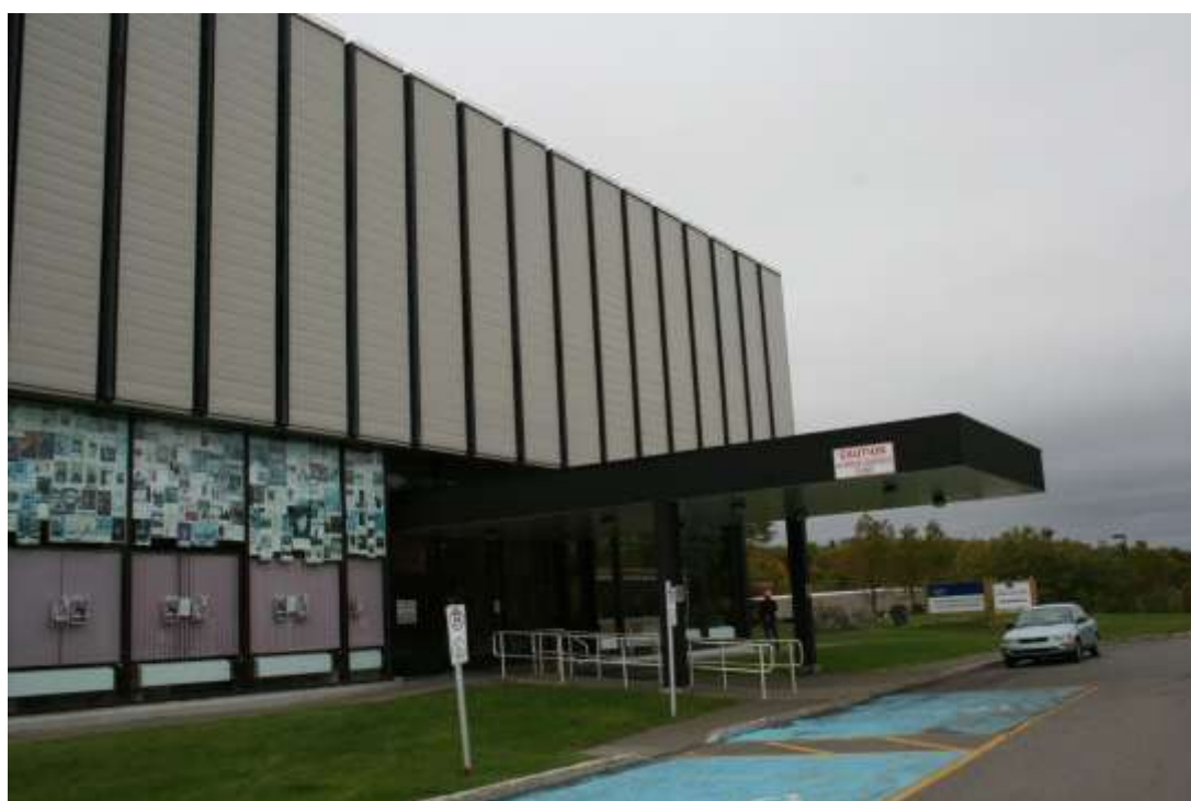
Přesunutý pavilon, Grand Falls-Windsor, 2009. Foto: Terezie Nekvindová.
