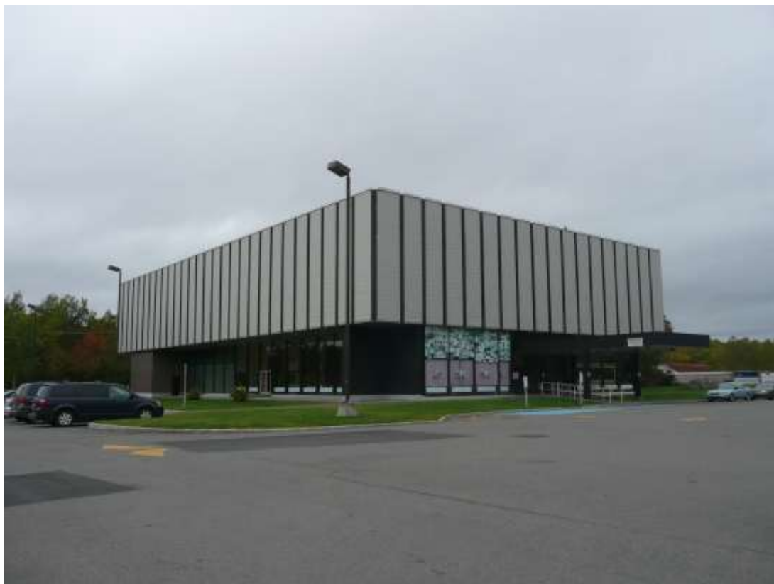
Přesunutý pavilon, Grand Falls-Windsor, 2009. Foto: Terezie Nekvindová.
