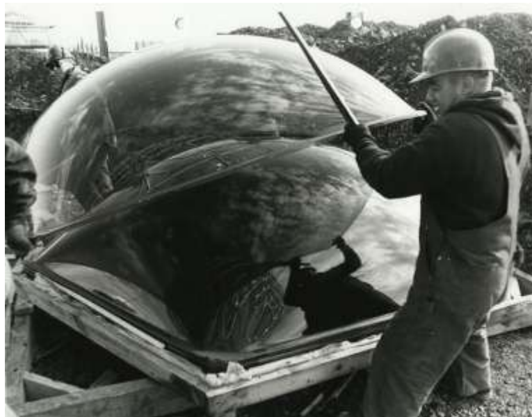
Stavba pavilonu USA. Foto: Miroslav Řepa.
