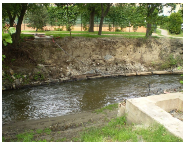
Obr. 25: Zbytek odstraněného mostu pro pěší v areálu Hamrsport (BOT020a-vlastní foto)
