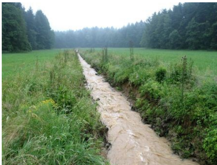
Obr. 2: Technická úprava Pekelského potoka u Zdislavic (Zdroj: Just, 2010).
