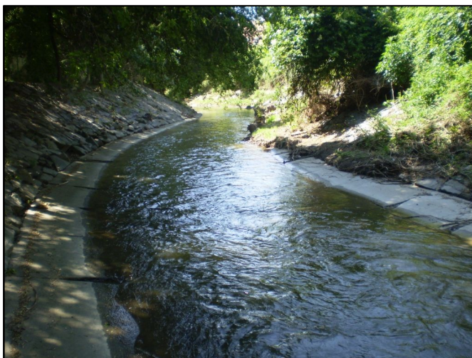
Obr. 35: Úprava dna betonem (BOT012).
