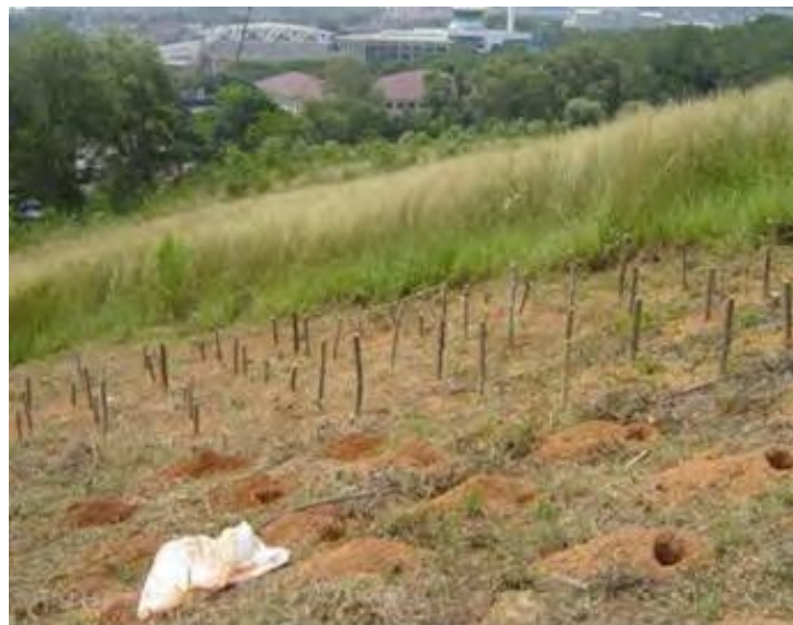
Obrázek 14: Instalace řízků na druhý svah (Mafian et. al., 2009).
