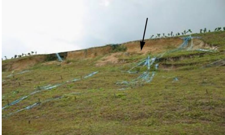
Obrázek 13: Instalace řízků na první svah (Mafian et. al., 2009).
