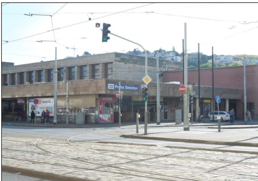
Obr. č. 4: Hlavní staniční budova nádraží Praha-Smíchov
