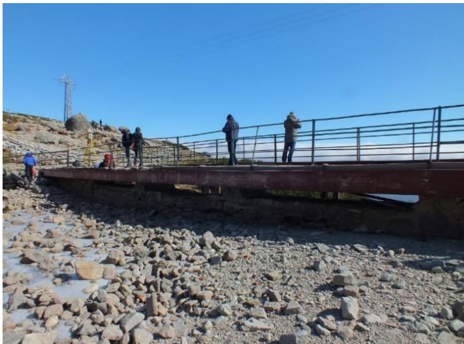
Obr. 4.24 – Umělá hráze Skalnatého plesa – pohled od jezera
