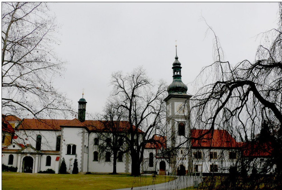
2. Praha-Zbraslav , bývalý cisterciácký klášter s kostelem sv. Jakuba a prelaturou. Druhá polovina 13. století a druhá polovina 17. století.
