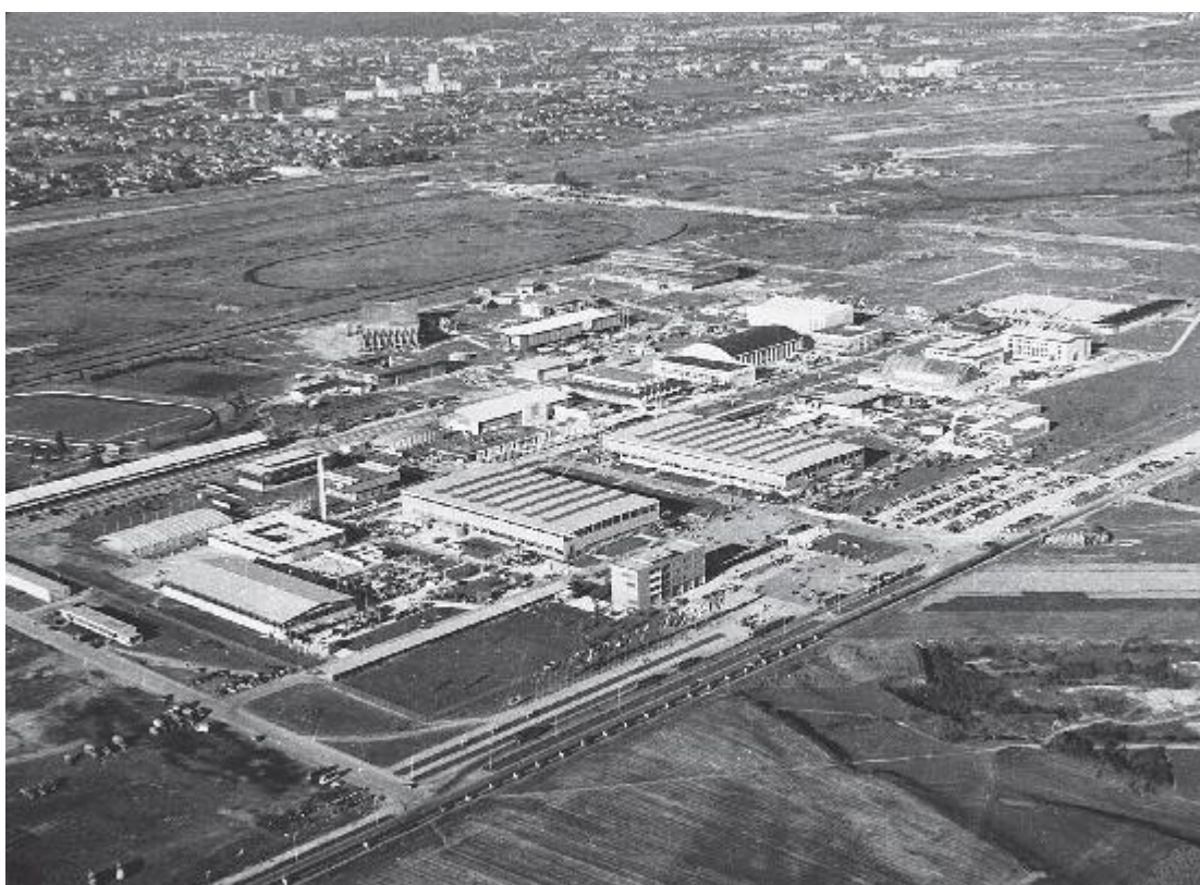
Příloha č. 4: Pohled na výstavbu záhřebského veletrhu v roce 1956.
