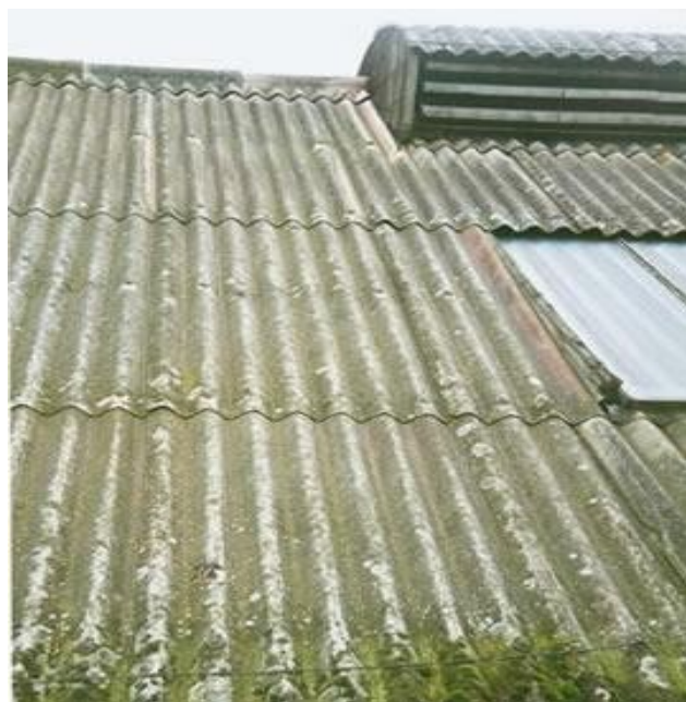
Obr. 8: Vlnitá střešní krytina [22].
