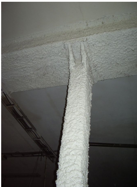
Obr. 7: Protipožární nástřík ocelové konstrukce [21].
