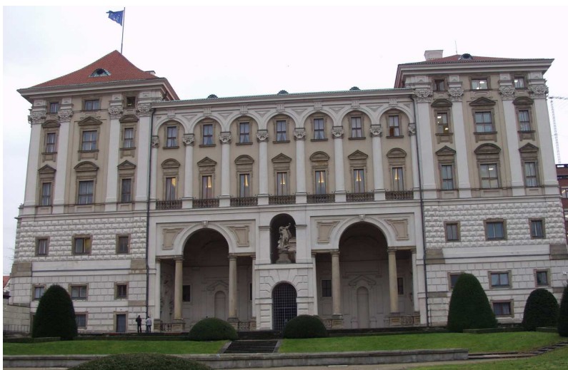
59. Francesco Carratti: Černínský palác, východní průčelí paláce po rekonstrukci Pavla Janáka v letech 1928-1934, 2012
