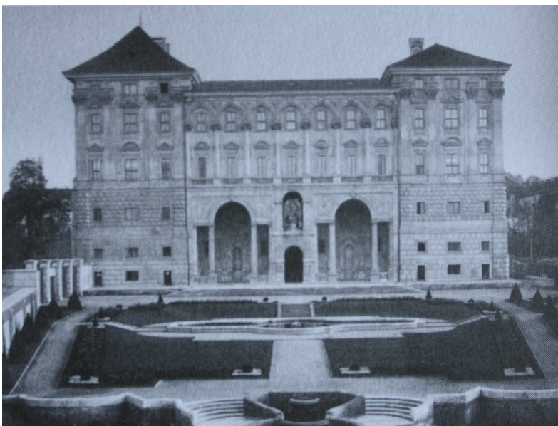
6. Pavel Janák: rekonstrukce Černínského paláce, 1928-1934
