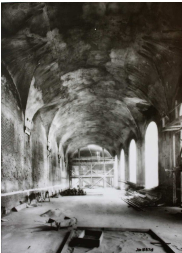
34. Míčovna Pražského hradu, 1946, interiér vyhořelé Míčovny
