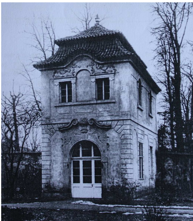
48. Antonín Haffenecker: centrální pavilon skleníku, 1731, pohled od jihovýchodu
