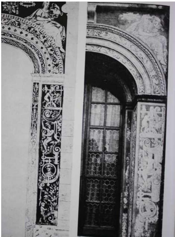
41. Míčovna Pražského hradu, kolem roku 1880 a 1953, srovnání kresby sgrafit od Jana Kouly a jejich stavu po obnově v roce 1953
