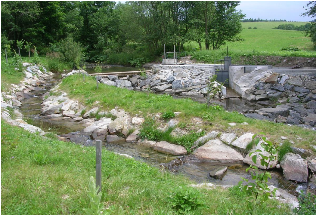
Obr. 9 V pozadí jez jako příklad stavby bránící migraci živočichů, který je ale vybaven rybím přechodem
