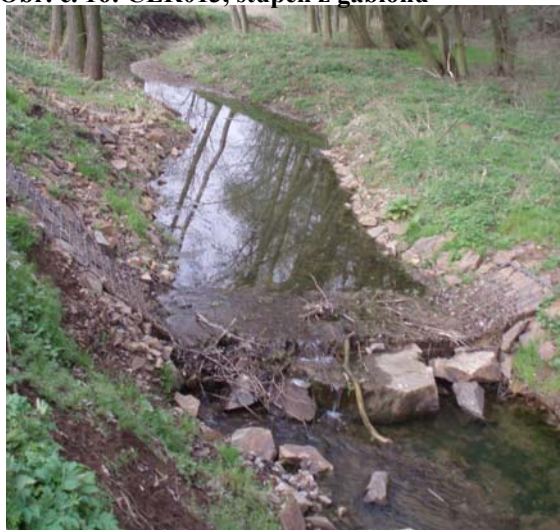
Obr. č. 16: CER013, stupeň z gabionů
