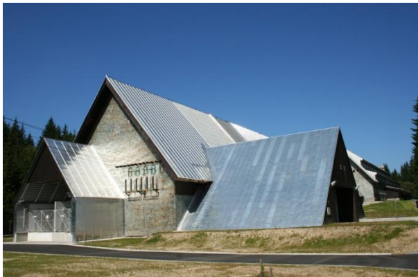
Obr. 1. Úpravna vody Souš (převzato z SMP CZ, online).
