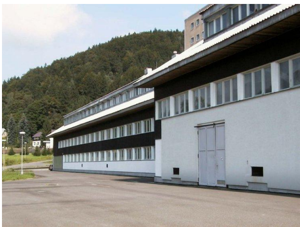
Obr. 2. Úpravna vody Bedřichov (převzato z SVS a.s., online)
