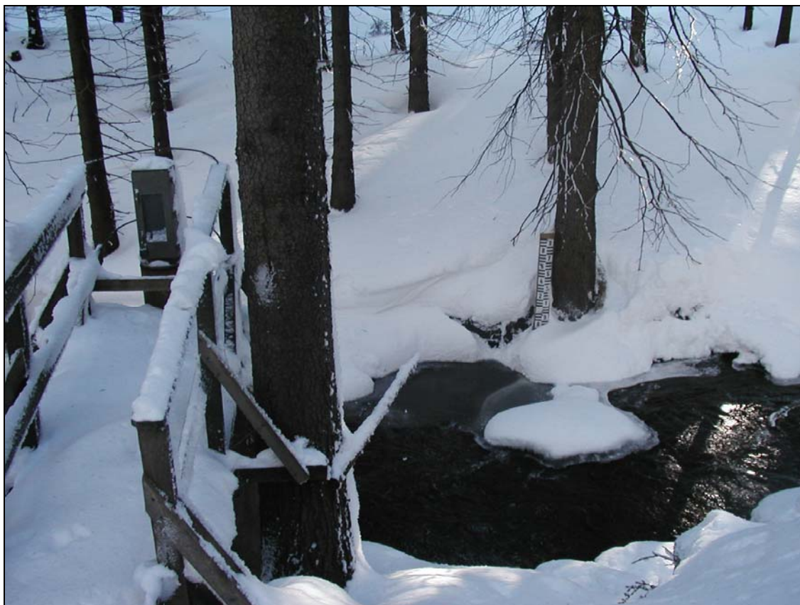
Obr. 4.2 - Vodoměrná stanice Chaloupky v zimě 2004/2005
