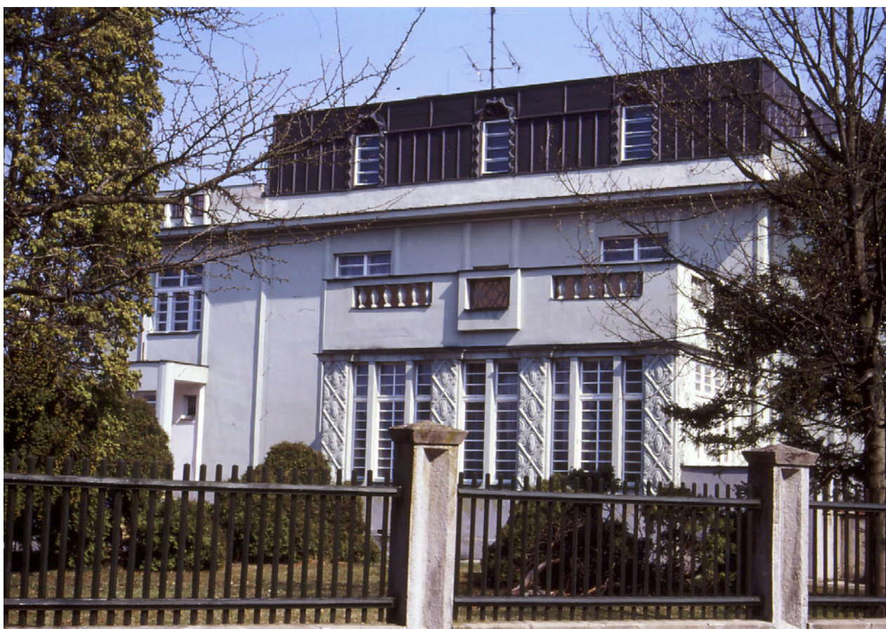
99 / Čerychova vila, západní průčelí s kubistickými prvky
