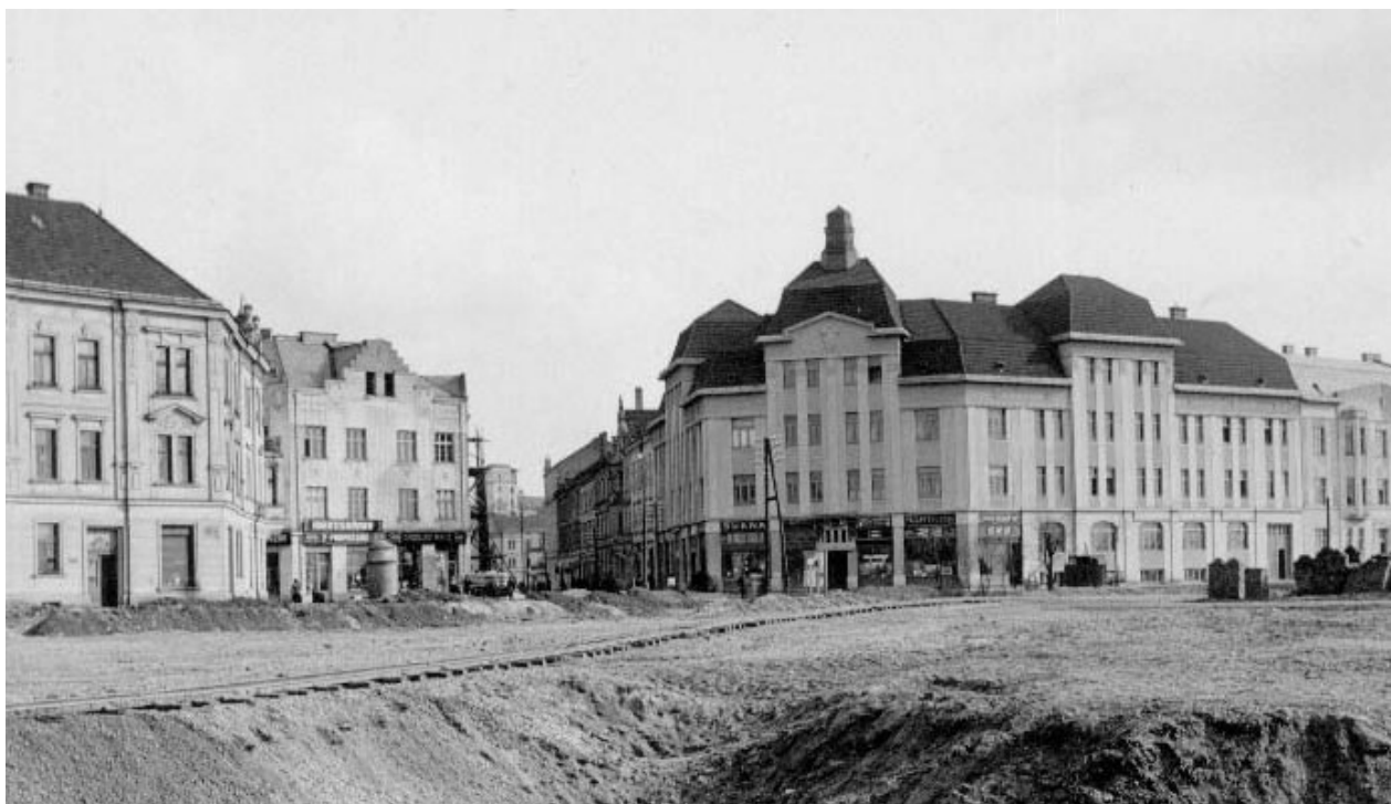
59 / Novostavba Živnostenského domu v prostoru budoucího Masarykova náměstí, 1911
