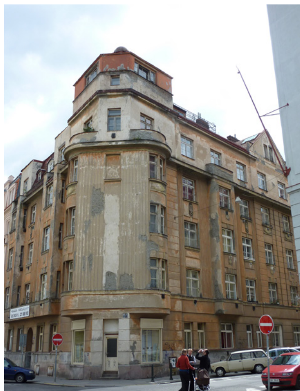
103 / Dům v ulici U Akademie, čp. 366, Praha-Bubeneč, současný stav
