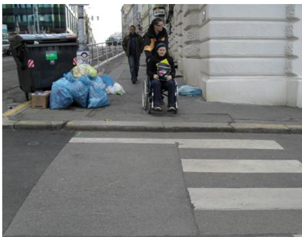
Obr. 4 špatně řešený přechod (chybí nájezd)
