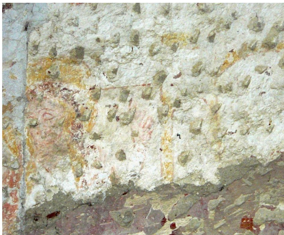
49. Boletice, kostel sv. Mikuláše, severní stěna presbytáře, neznámý námět, detail, 1320 – 40.
