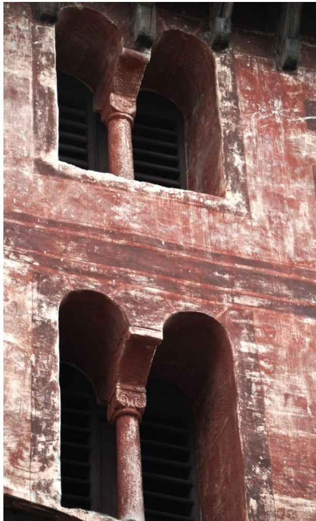
4. Boletice, kostel sv. Mikuláše, konec 12. století, sdužená okna věže
