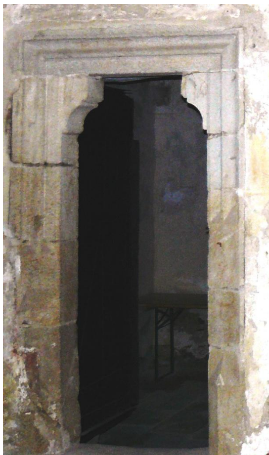
13. Boletice, kostel sv. Mikuláše, severní portál vedoucí do sakristie, 1410 – 20.
