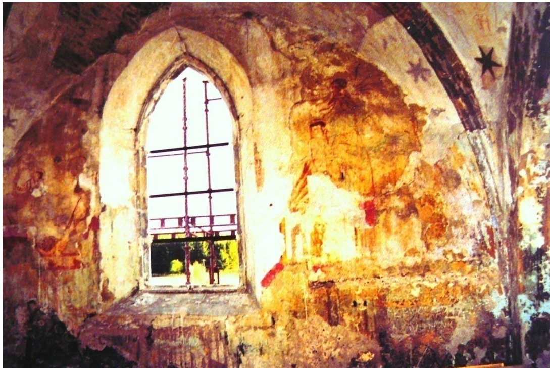
20. Polná na Šumavě, kostel sv. Martina, před 1350, výmalba presbytáře před restaurováním.
