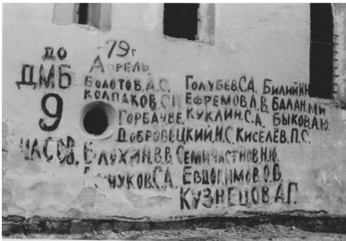
16. Boletice, jižní fasáda, detail.
