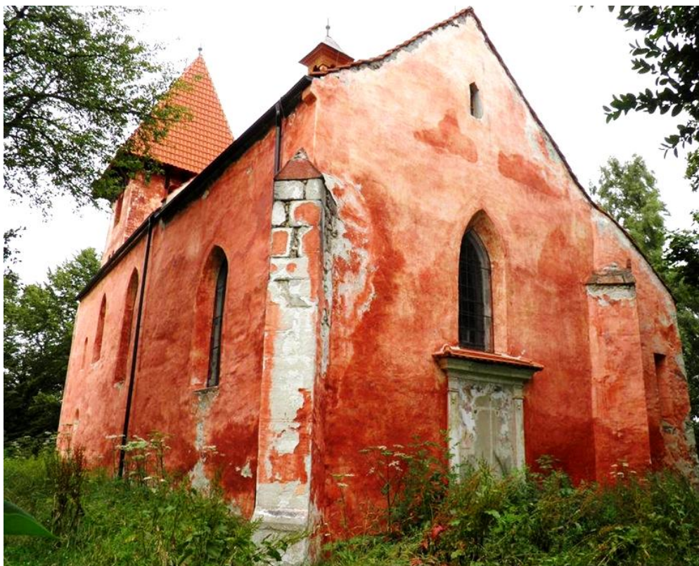
5. Boletice, kostel sv. Mikuláše, konec 12. století, pohled od západu.
