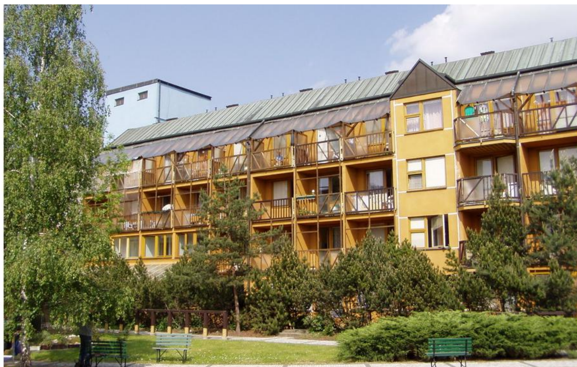
Zdroj: Domov pro seniory Chodov
