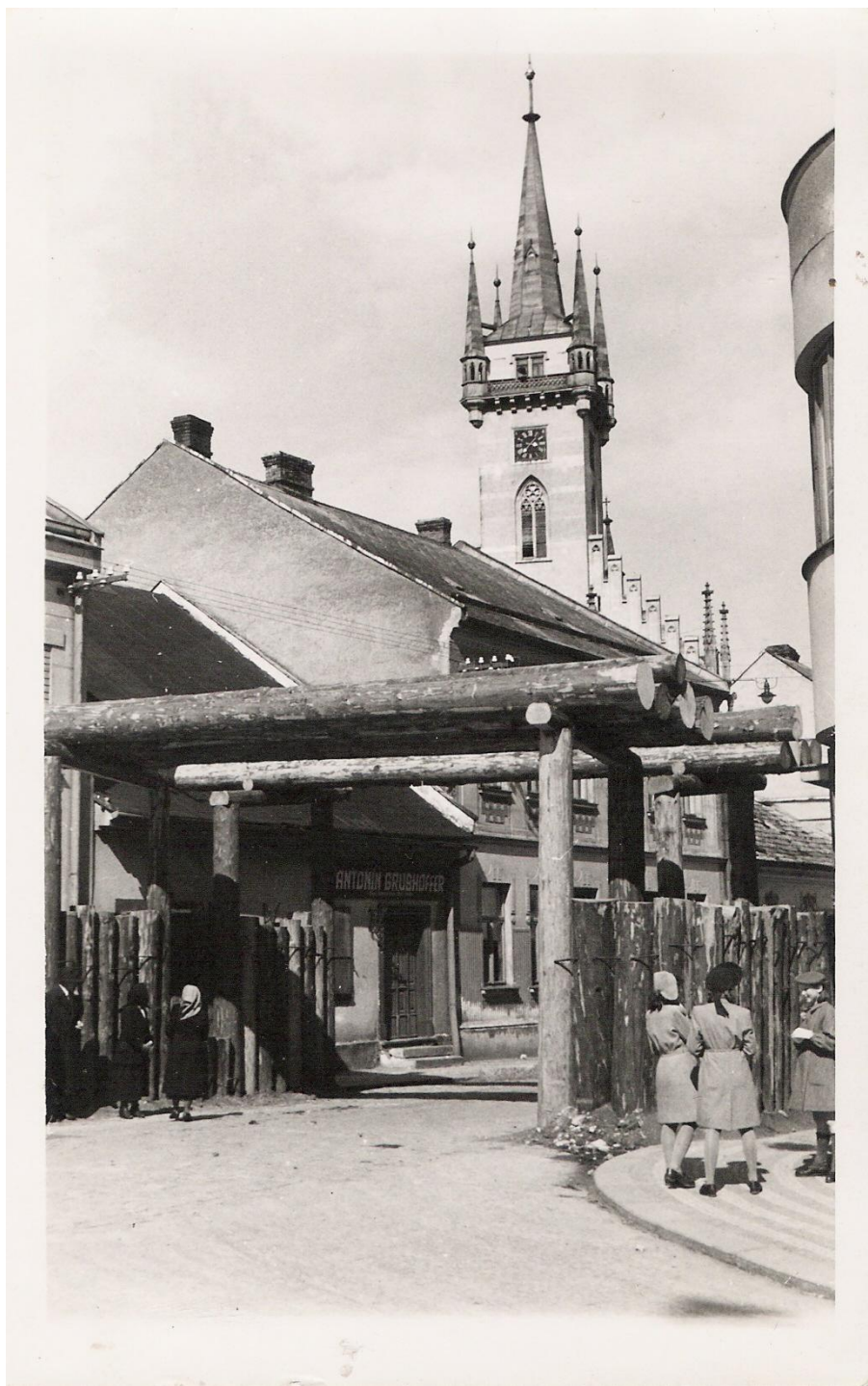
Německé protitankové zátarasy v Poličce, pohled na výjezd z Riegrovy ulice 208
