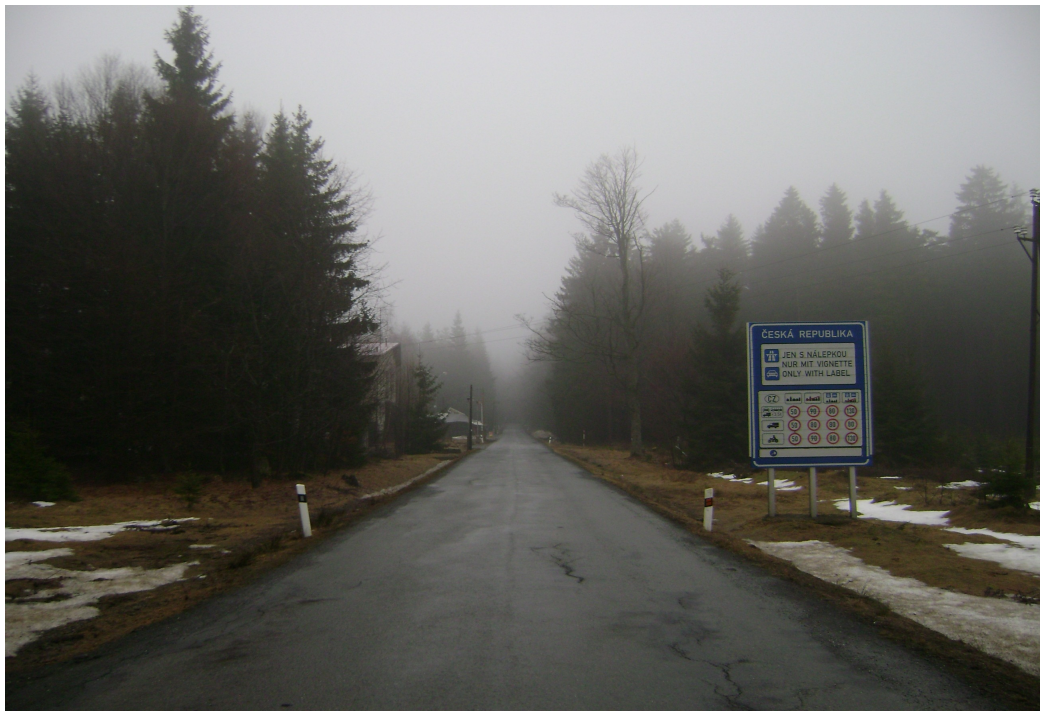
Foto č. 2: Hraniční přechod Pavlův Studenec – Bärnau, pohled na bývalou českou celnici II.
