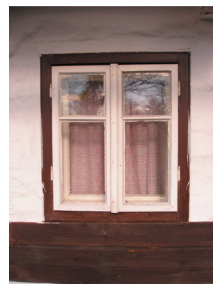
Tohle okno má tabule skleněné a rámečky dřevěné – jak výstižný popis.
