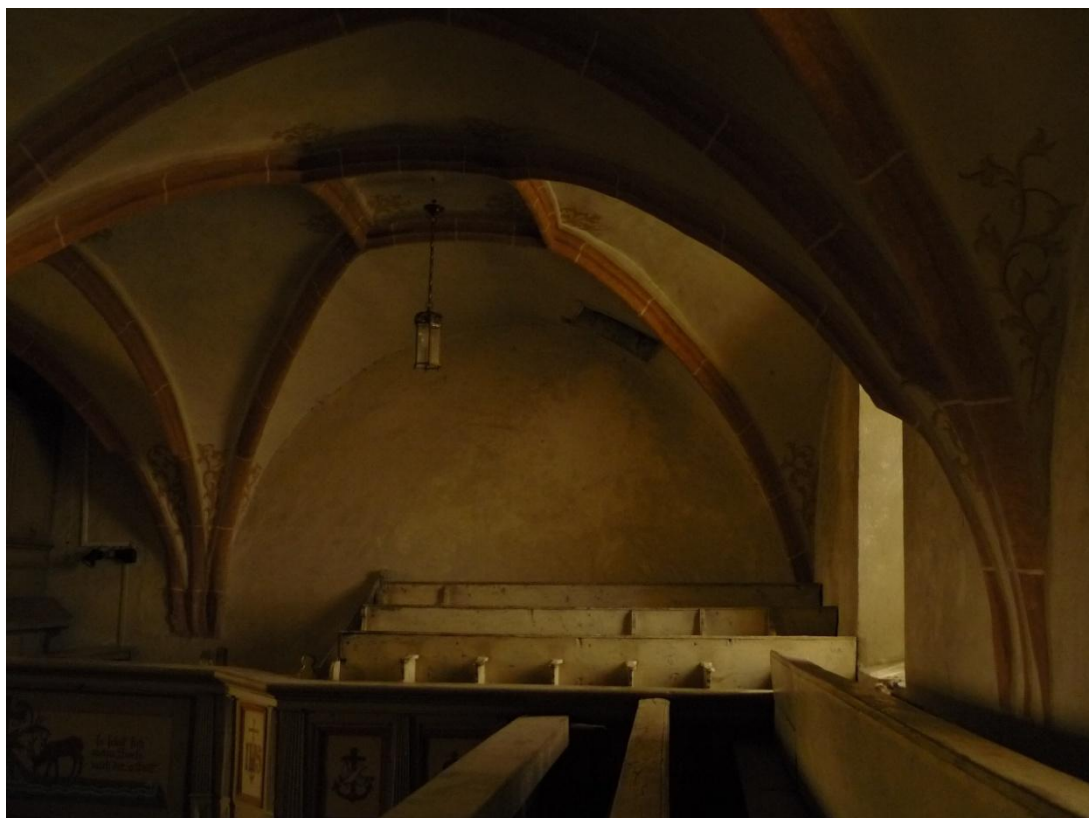
15. Ves, kostel sv. Vavřince, pohled na severozápadní pole klenby lodi s výběhy žeber.
