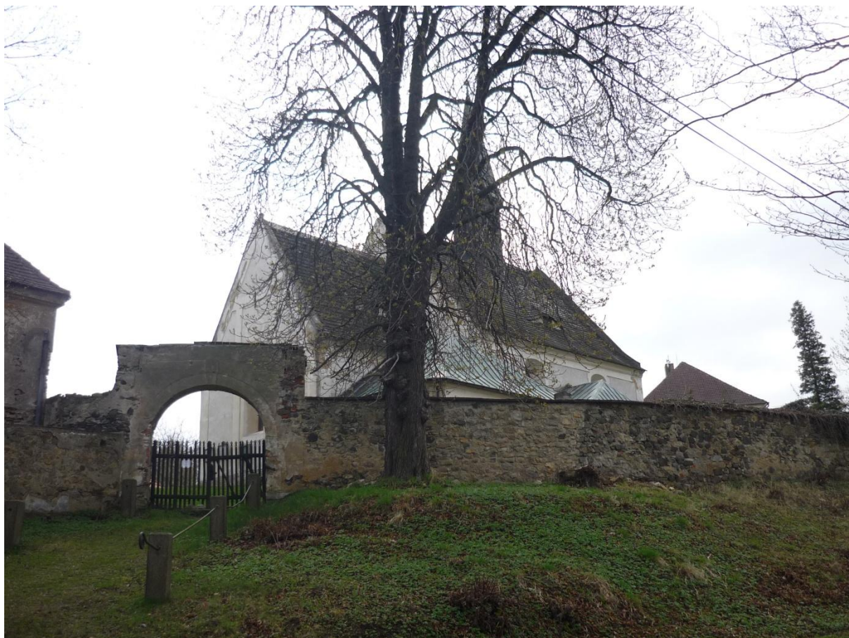
3. Ves, kostel sv. Vavřince, pohled od severovýchodu.
