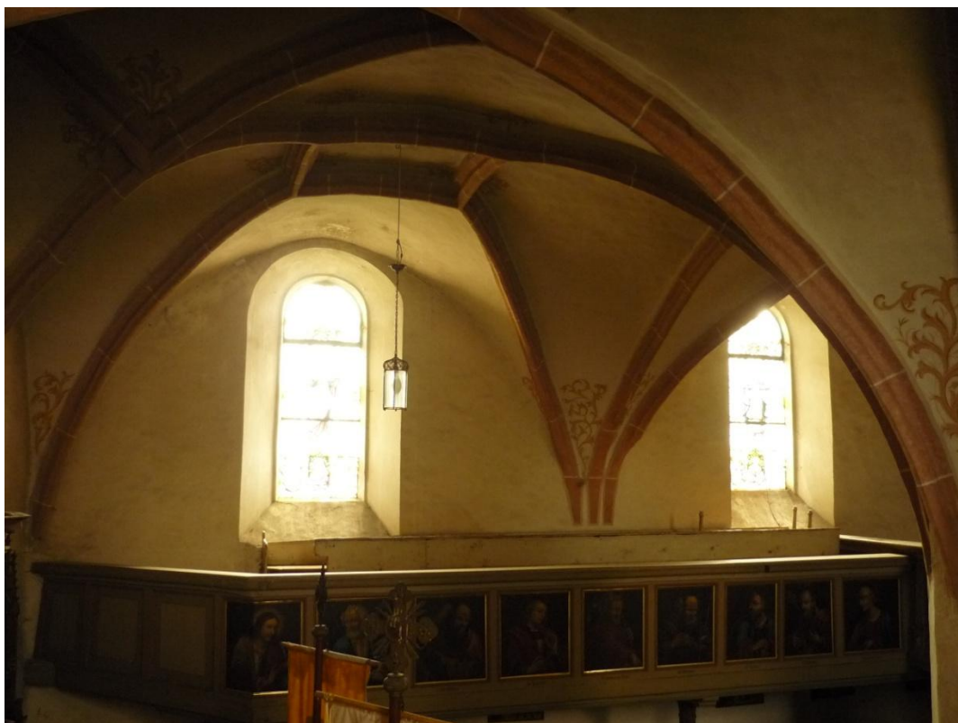
14. Ves, kostel sv. Vavřince, pohled na jihovýchodní pole klenby lodi s výběhy žeber.
