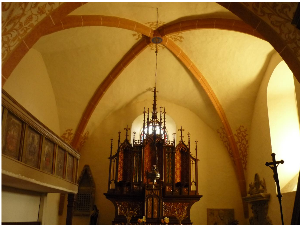
6. Ves, kostel sv. Vavřince, pohled na klenbu presbytáře.
