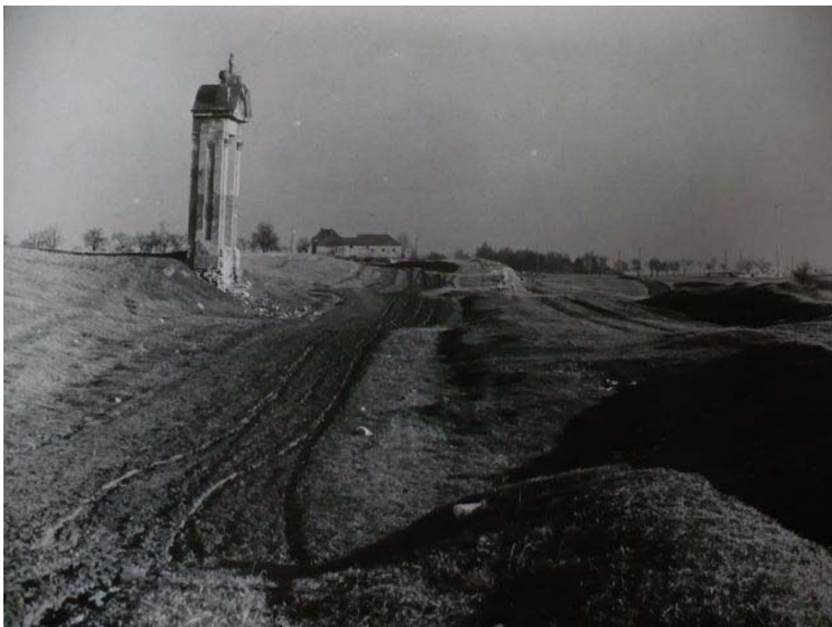
Obr. č. 1. Zbytek původní středověké cesty u kaple č.V. byl zaznamenán na fotografii ještě v roce 1923, v pozadí usedlost Ladronka. Dnes stojí kaple zády k ulici Kukulova, její výklenek je obrácen do křoví.... (AMP, sbírka fotografií, , sig. I 4141, foto Bernau 1923).
