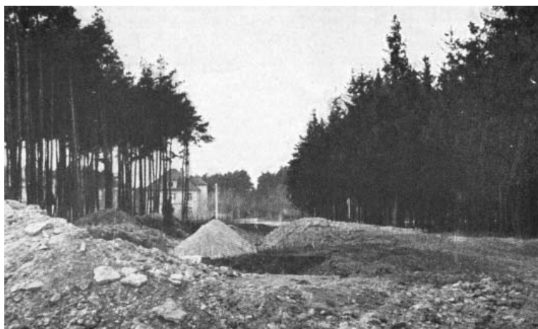
Ladislav Žák: Zhoubný stavební ruch - Klánovice u Prahy, 1938. Reprodukce: Ladislav ŽÁK: Obytná krajina, Praha 1947, 81.
