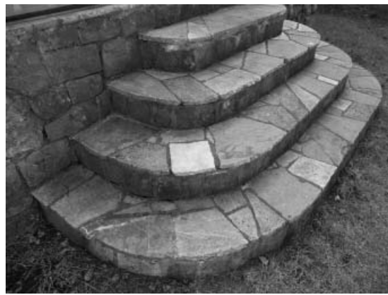
Schodiště na terasu u domu Metoděje Chytila, 1963-1967.
