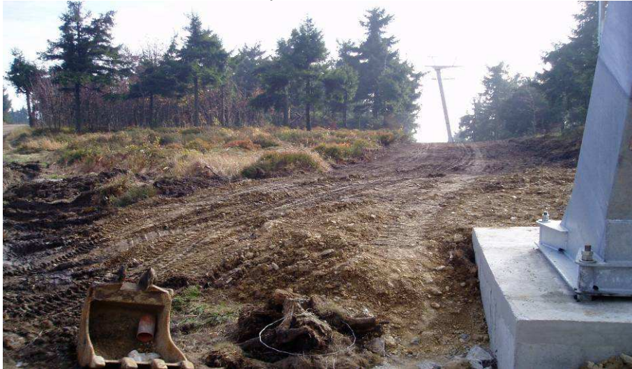
Obr. 6. 10. Stavba lanovek – Vyhlídková cesta
