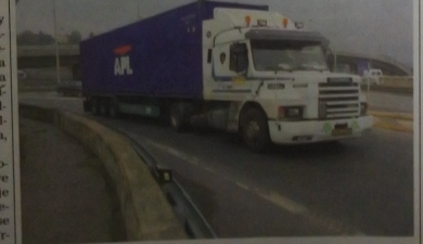
Těžké kamiony ničí povrch, protože s tak hustou dopravou projekt vůbec nepočítal. FOTO: MAFA - MICHAL ŠVAČEK
