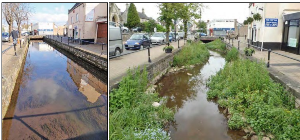
Obr. 13 – Porovnání referenčního a výsledného stavu revitalizačního projektu v intravilánu města Midsommer Norton. Zdroj: (Woodland Water & Gardens and D. Longley, 2011 in RRC Case study 3.10)
