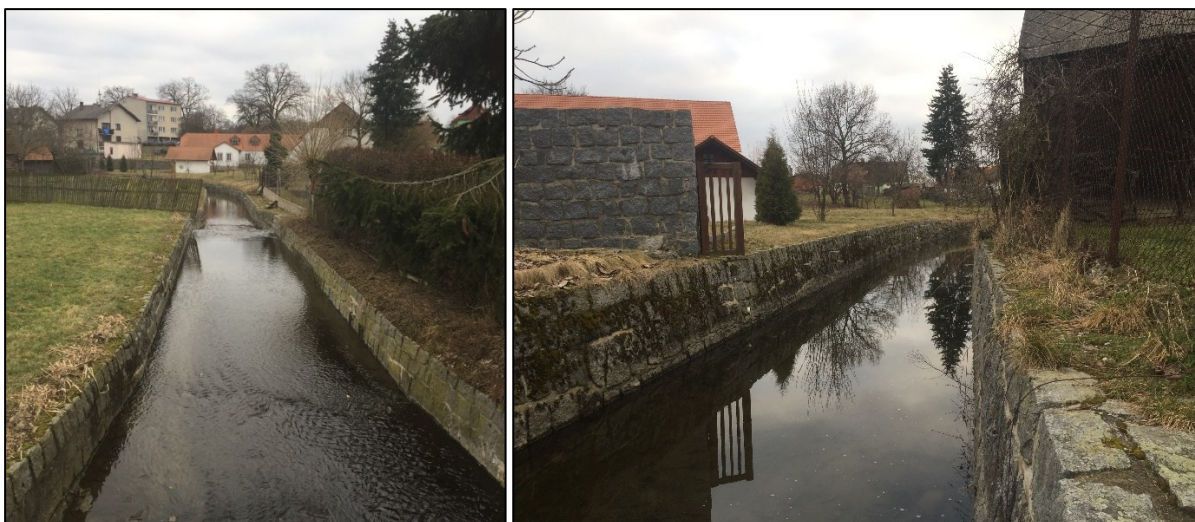
Obr. 2 – Znemožnění boční migrace koryta v sevřeném obdélníkovém profilu. Zdroj: (archiv autora, 27.02.2021, Zalužanský potok protínající intravilán obce Lety)
