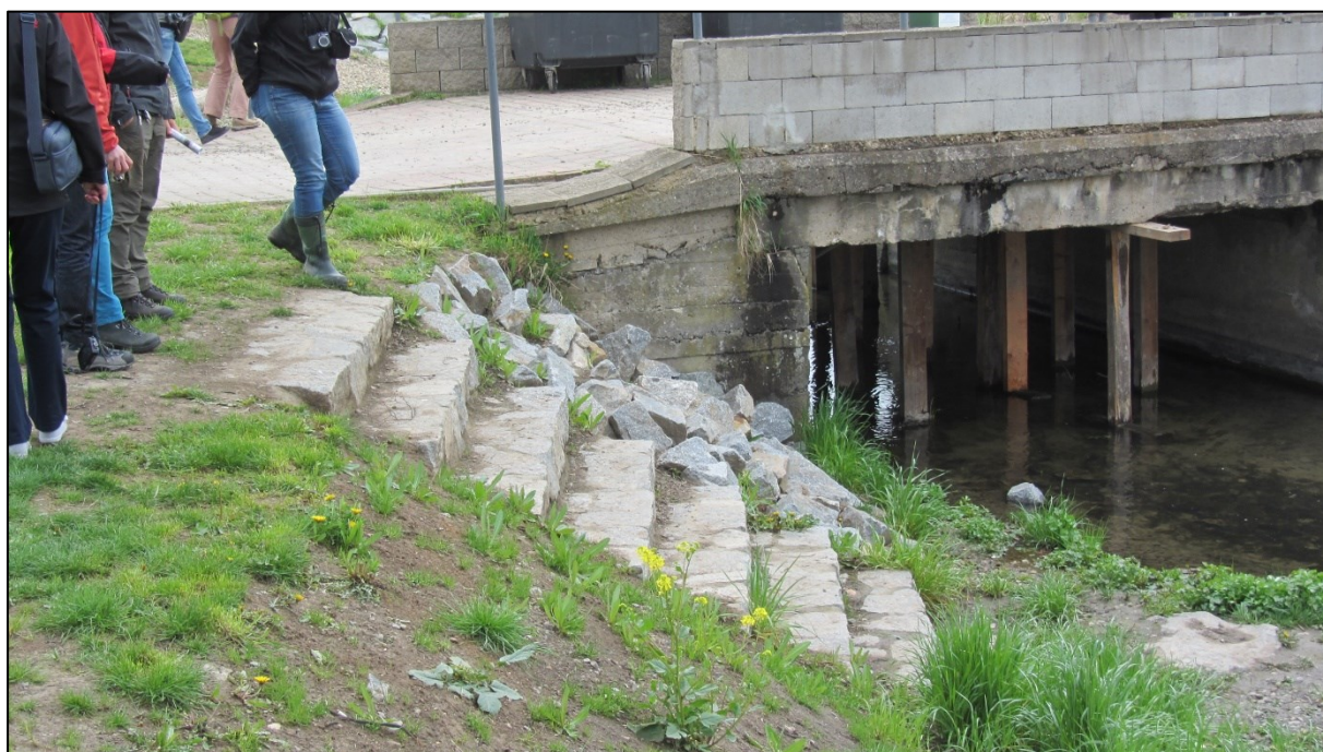
Obr. 75 – Ukázka začlenění přístupu z plochých kamenů. Je možné použít buď solitérní kamenivo skládané do horizontální linie anebo již prefabrikovanou horizontální schodnici. Obě řešení mají své výhody i nevýhody. Výhodou solitérně skládaných kusů kameniva je jejich přirozenější vzhled, nicméně vyžadují vyšší míru údržby, neboť v mezírkách mezi nimi dochází k sukcesním procesům. Zdroj: (foto Milada Matoušková)
