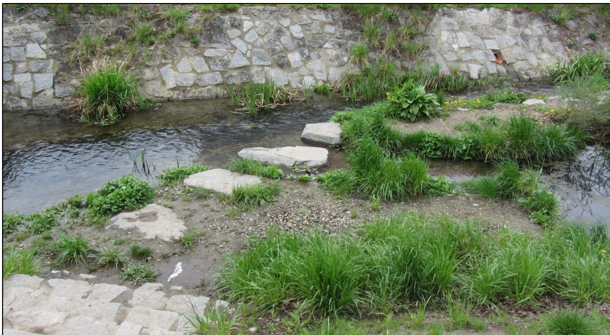
Obr. 76 – Ukázka variantního řešení kynety „B“ – přechod toku „suchou nohou“. Balvany je třeba zapustit do říčního substrátu, aby byly stabilní a nedošlo k jejich odplavení při vyšších průtocích. Zdroj: (foto Milada Matoušková)
