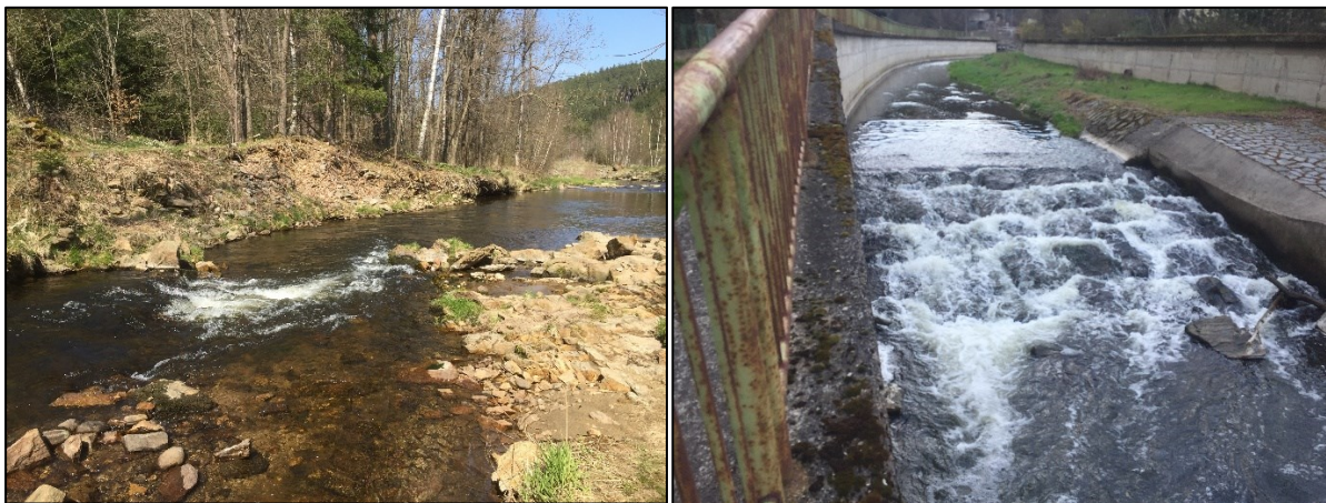
Obr. 9 – Ukázky přirozené a umělé diverzifikace proudění. Na snímku vlevo je vyobrazena přirozená změna charakteru proudění na řece Blanici (úsek mezi Zábrdským a Podedvorským mlýnem). Na snímku vpravo poté uměle introdukovaná změna charakteru proudění pomocí kamenného (balvanitého) skluzu na řece Kocábě ve Štěchovicích. Zdroj: (archiv autora, 20.04.2021 (Kocába), 09.05.2021 (Blanice))
