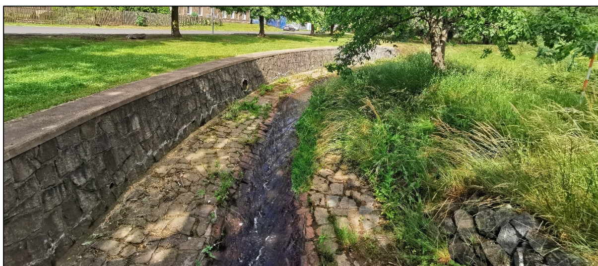
Obr. 72 – Pravobřežní zeď z kamenné dlažby v prostoru profilu P4. Zdroj: (foto Milada Matoušková)
