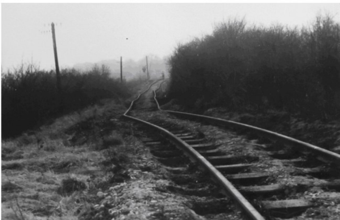
Obr. 18 - Deformace železnice při sesuvu v r. 1981 - (Rybář, 1983).
