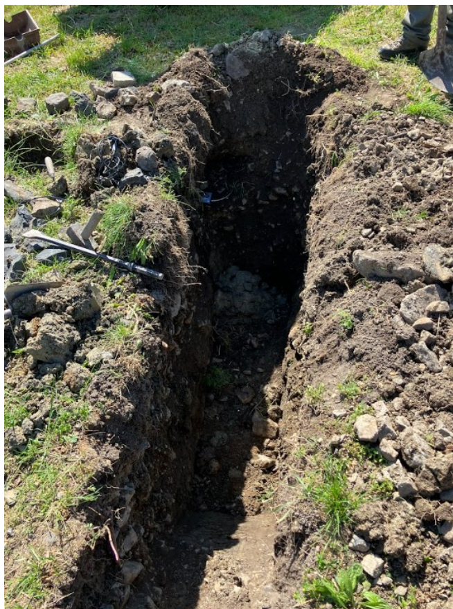
Obr. 26 - Kopaná sonda provedena na lokalitě.
