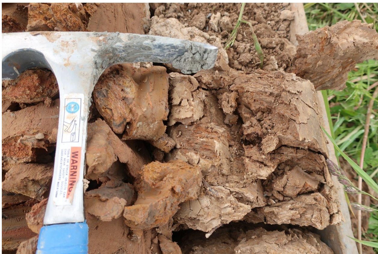
Obr. 44 - Zcela zvětralý slínovec jevící známky původní horninové stavby - GT3. Valdštejsko 2025.
