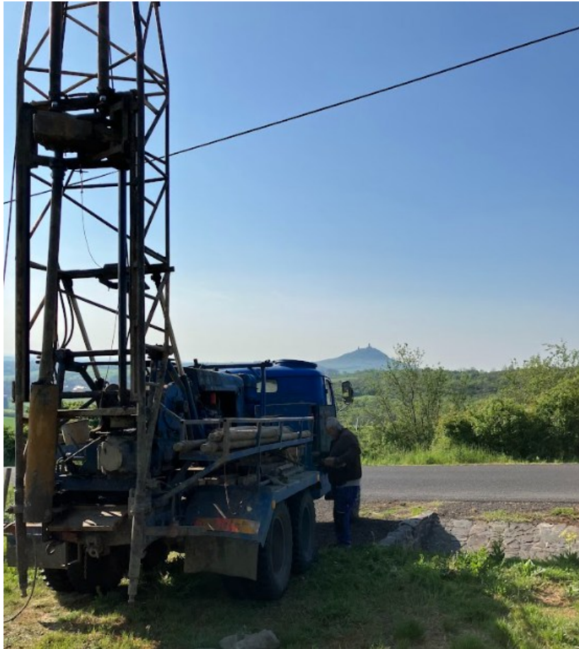
Obr. 24 - Vrtací souprava na lokalitě, příklepové vrtání s roubíkovou korunkou bez výplachu, průměr 195 mm.
