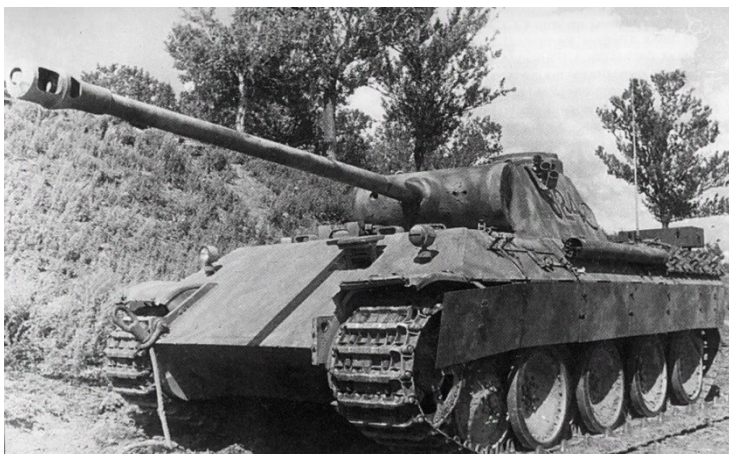
Obr. č. 24: Poměr cena výkon jako hlavní atribut tanku. Složitost německých tanků vedla k jejich vysoké ceně, poměrně velké poruchovosti a tedy náročnosti oprav v polních podmínkách. Ve skutečnosti byly tak ztráty způsobeny spíše opuštěním strojů kvůli mechanickým závadám – jako tento PzKpfw V u Kurska. Zdroj: www.albumwar2.com 239
