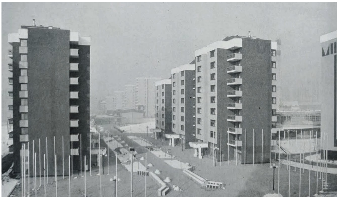
Obrázek č. 33 – Olympijská vesnička Mojmiło těsně po vybudování.
