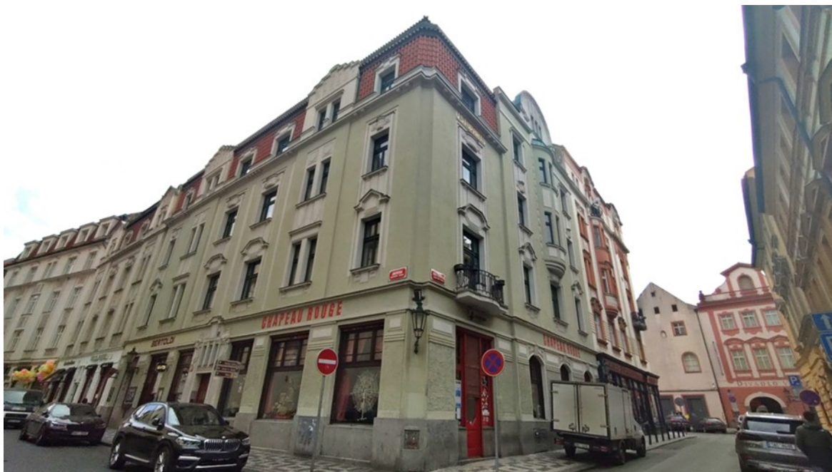
Obr. 15 Dům čp. 647 na rohu Malé Štupartské a Jakubské ulice, (foto autor, 2025).
