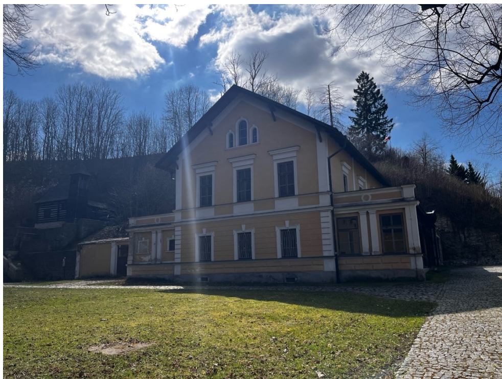
Obrázek 23: Lázeňská budova a Fráterka v roce 2025.
