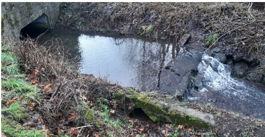
Obrázek 10: rozdělovací objekt na toku Dubá (zdroj: archiv autora)
