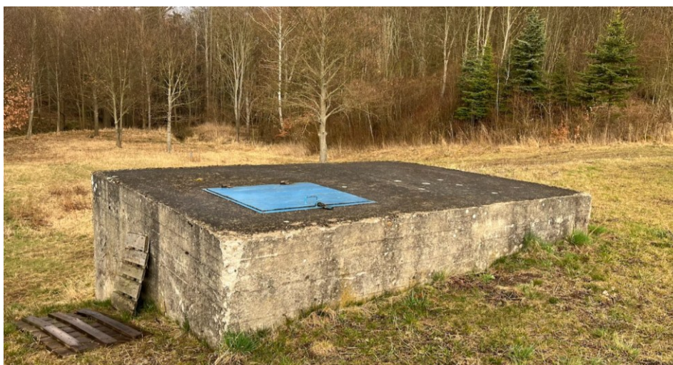
Obrázek 26: šachta s vodoměrem (foto: archiv autora)
