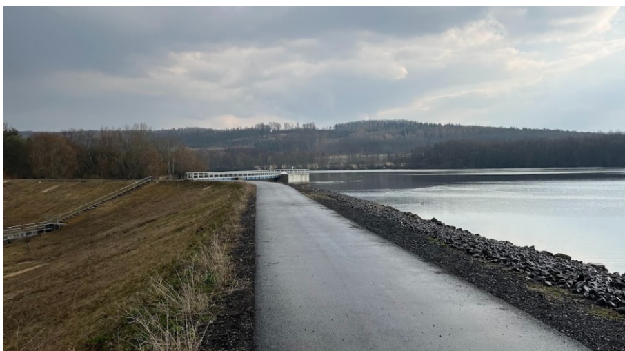
Obrázek 9: hráz vodní nádrže Sedlec (zdroj: archiv autora)
