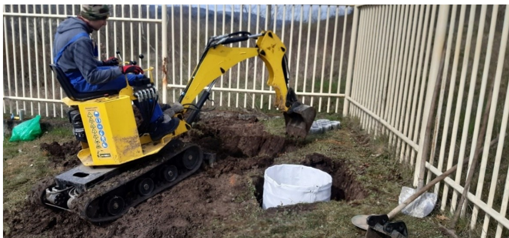
Obrázek 27: výkopové práce minibagrem (foto: archiv autora)
