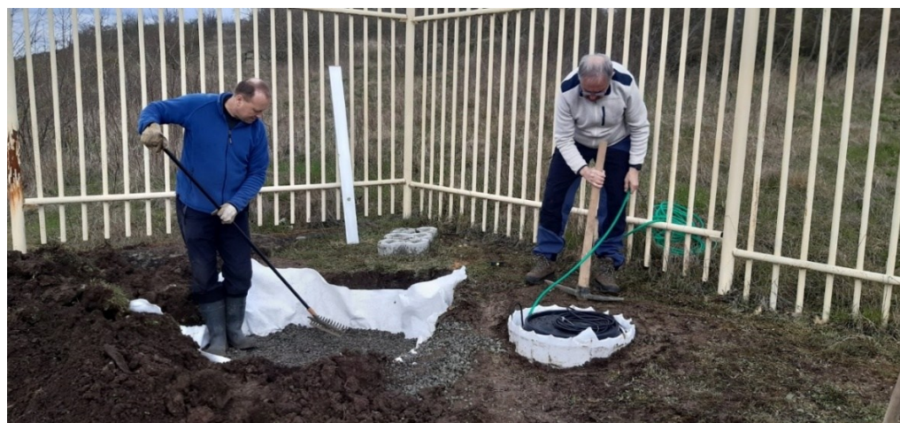
Obrázek 28: příprava instalace výparoměru (foto: archiv autora)
