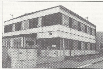
Budova U Starého stadionu 1379, současné sídlo letopisců. Brzy se k nim nastěhují městští strážníci.
