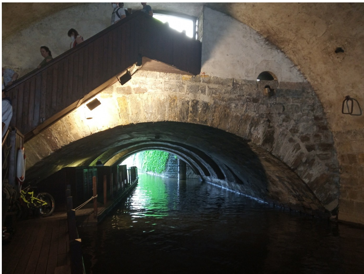
Příloha č. 3: Kompletně zachovalý oblouk Juditina mostu u kláštera křižovníků (foto autor 11. srpna 2021)
