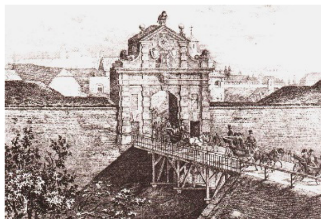
Po otevření brány v roce 1841 do ní vedl dřevěný most přes hradební příkop. (Zdroj obou fotografií: https://vysehradskej.cz/leopoldova-brana/ )
