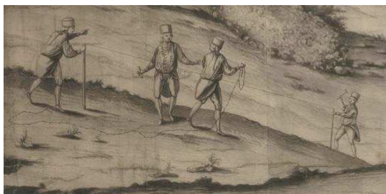
Obr. 34 Průběh povrchového vyměřování pomocí sklonoměru zavěšeného na provazci pro montánní účely na mapě.
